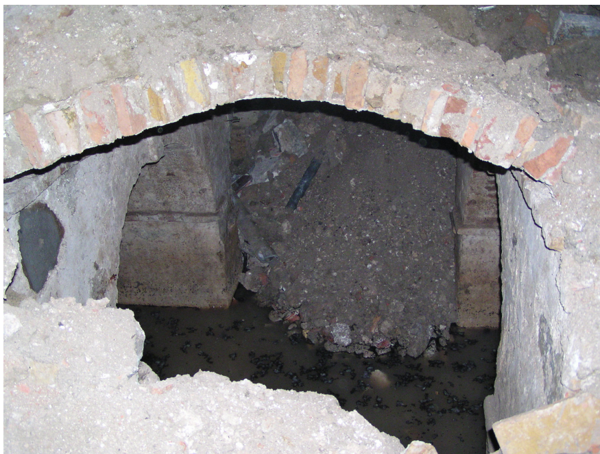
Slika 8: Najdeni podzemni prostori pri širokem izkopu
