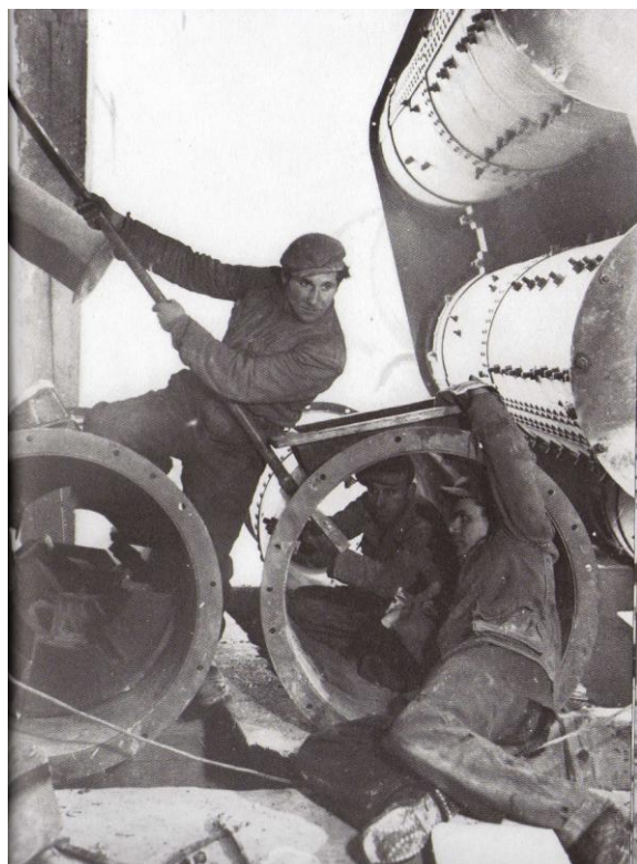
Slika 21: Delavci cementarne med vzdrževalnimi deli na peči »Krupp«
