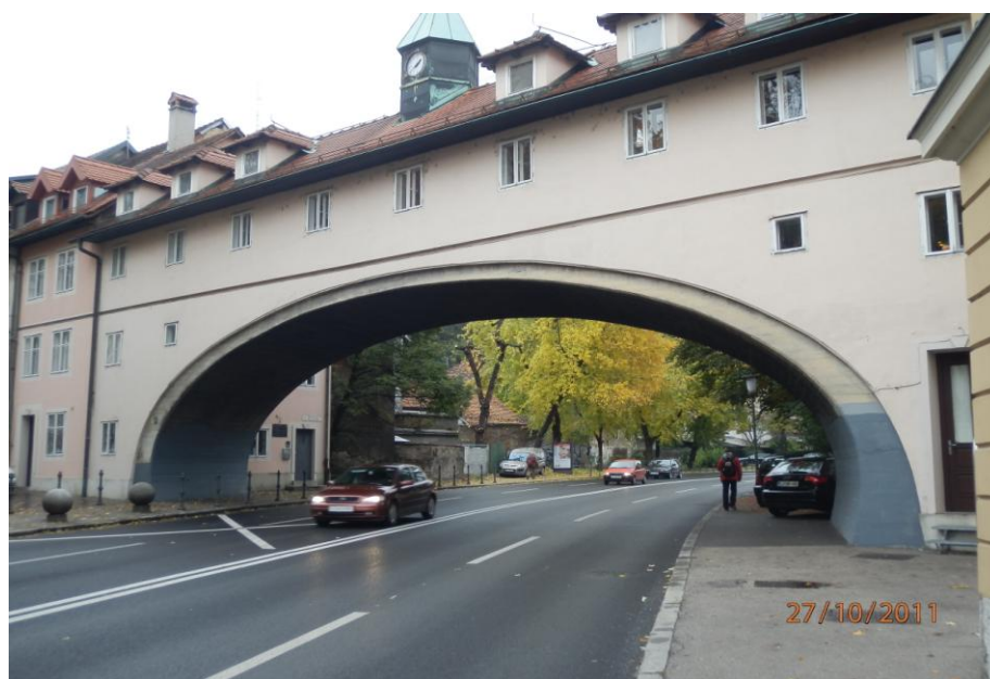
Slika 10: Primer prikaza stavbe nad cestiščem (stavba 364)
