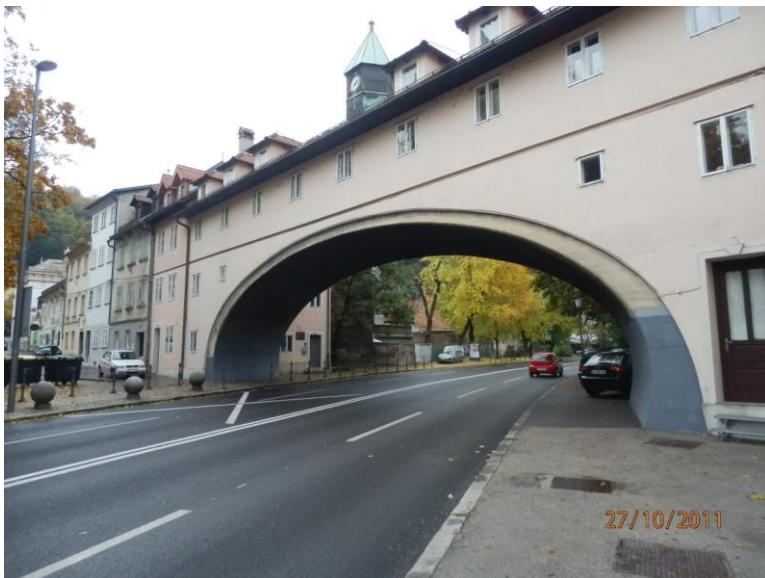
Slika 25: Karlovška cesta – prikaz stavbe nad voziščem
