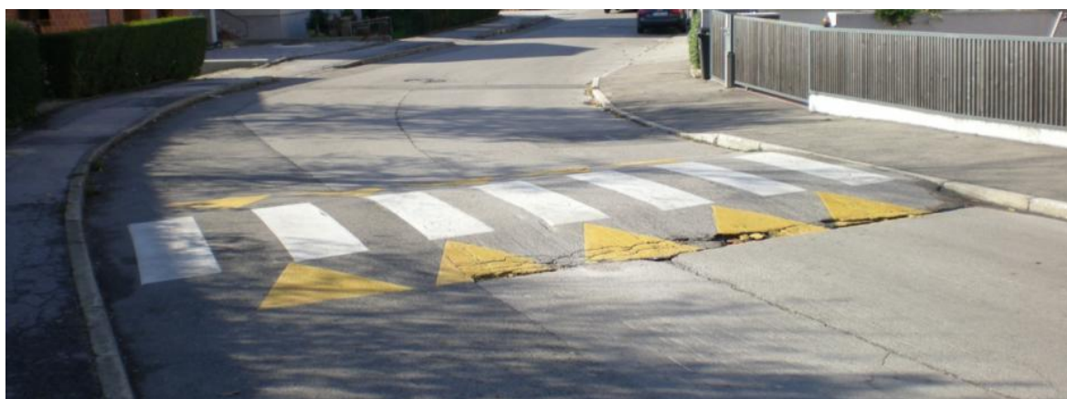
Slika 17: Grbina deloma trapezne deloma sinusoidne oblike na Gortanovi ulici.
