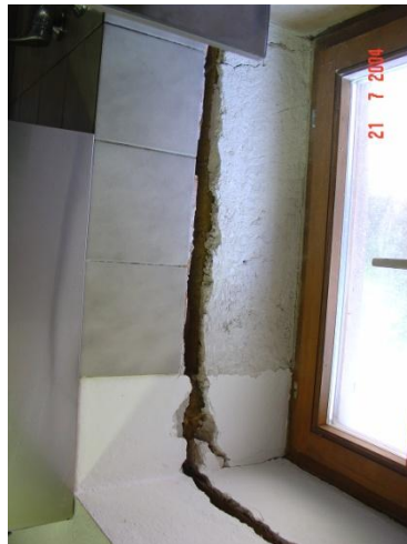
Slika 9: Primer razslojitve kamnitega zidu (Foto: Dolinšek, B. 2004)
