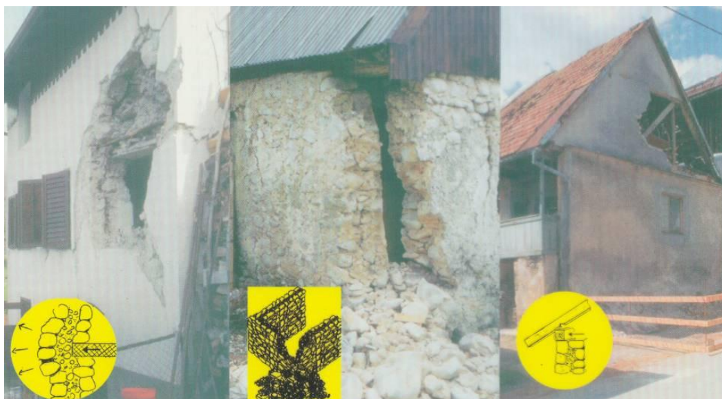
Slika 5: Elementi ranljivosti kamnitih stavb Posočja (Dolinšek, B. 2004)
