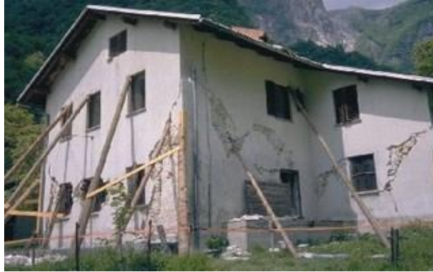
Slika 4: Tipične poškodbe po potresu leta 1998 (Foto: Hrovatin, A 1998)
