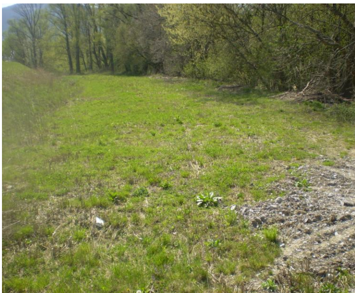
Slika 23: Prostor kjer se postavi gradbiščne provizorije (Foto: Bojan Bazilija, 22. 03. 2011)
