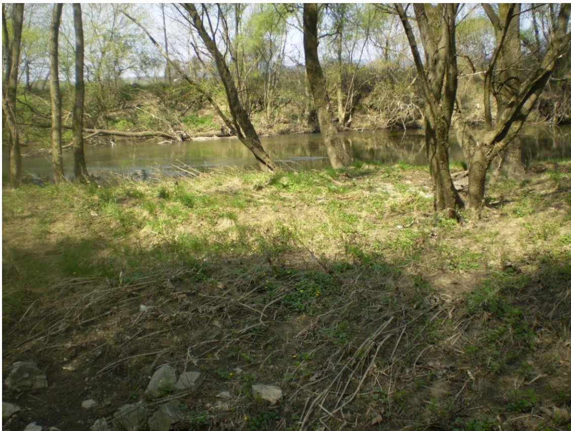
Slika 10: Pogled na reko Vipavo, kjer se izdelava kamnito drčo in preliv (Foto: Bojan Bazilija, 22. 03. 2011)
