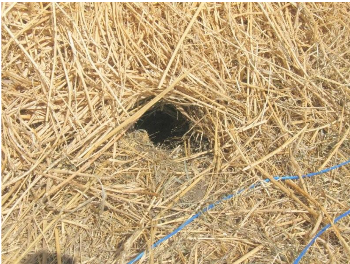
Slika 2: Takšne odprtine moramo med gradnjo nujno zapolniti s slamo ali mešanico slame in ilovice.
