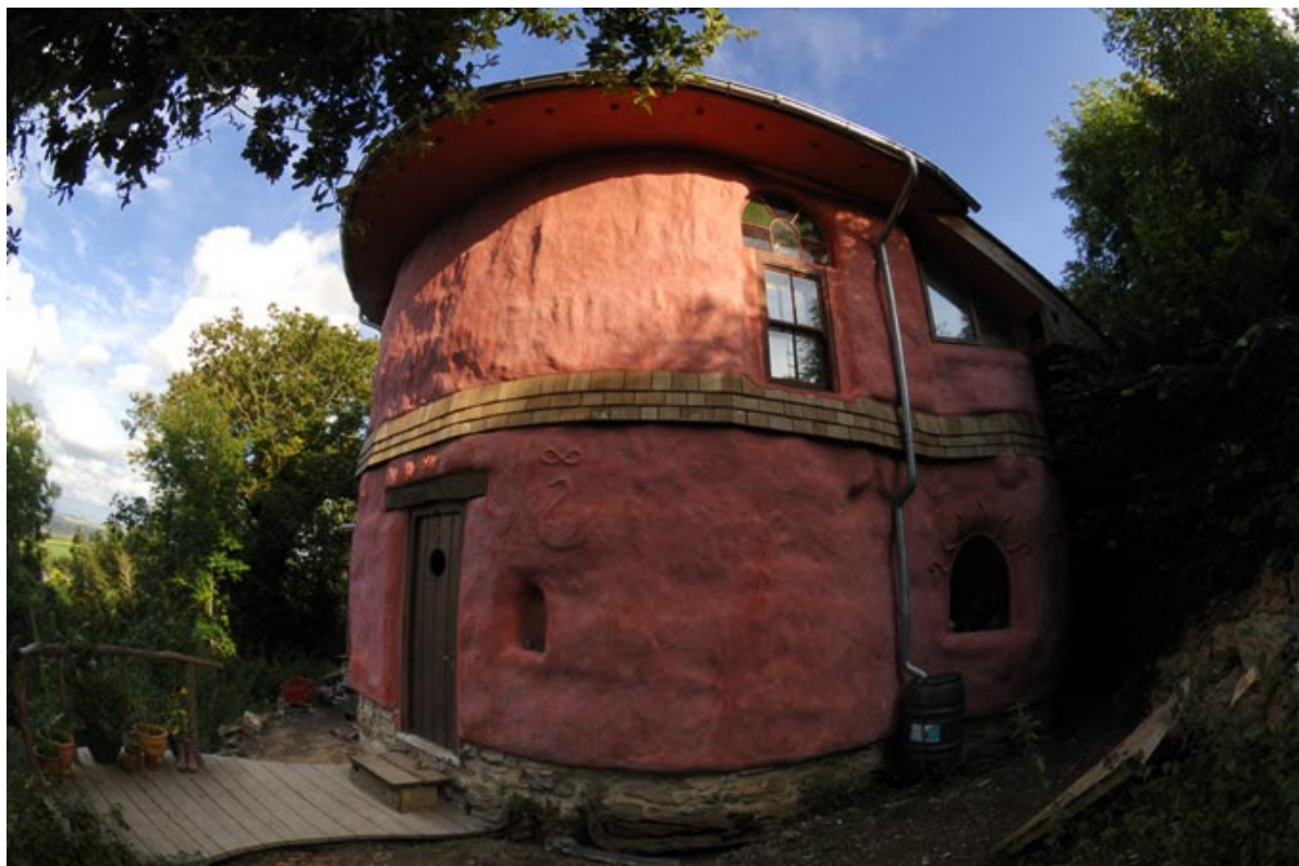
Slika 25: Prva dvonadstropna samonosilna hiša iz slamnatih bal v Veliki Britaniji (vir: Domen Zupan)
