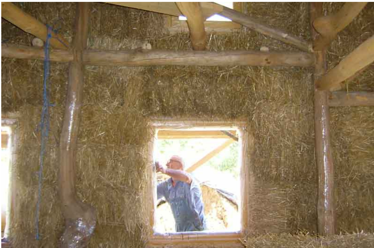
Slika 26: Bodoča dnevna soba v hiši, ki jo je zgradil Kristijan Zver: lepo je vidna osnovna lesena nosilna konstrukcija in stena iz slamnatih bal na zunanji strani (vir: Luka Lampret)
