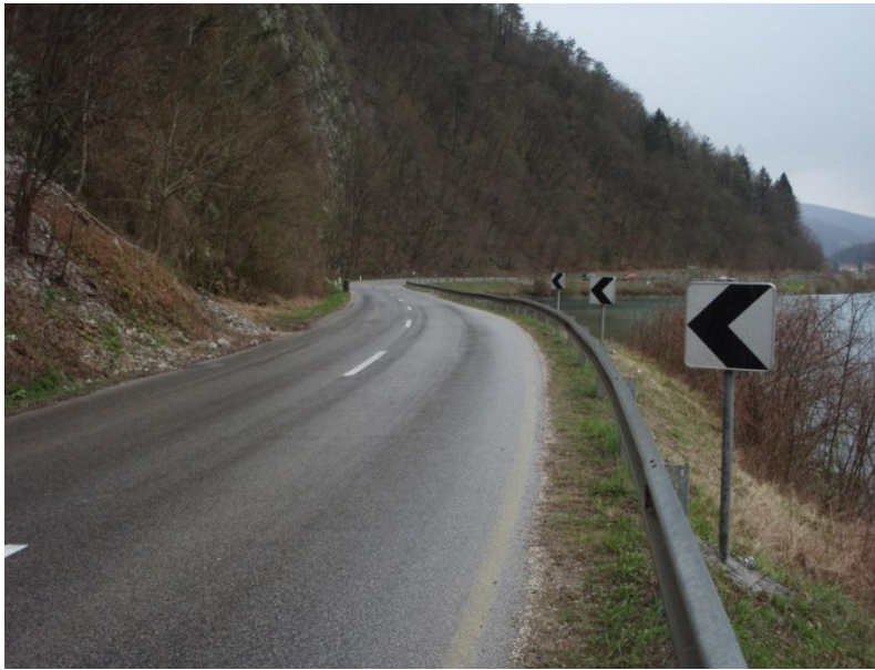
Slika 60: Dolvodni pogled na obravnavani odsek.
