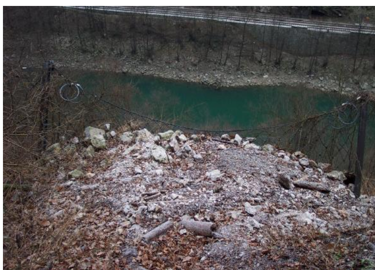
Slika 14: Povsem zapolnjena varovalna ograja, ki ni več funkcionalna.
