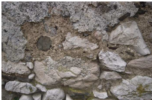
Slika 7: Nearmiran zid na zunanji strani
