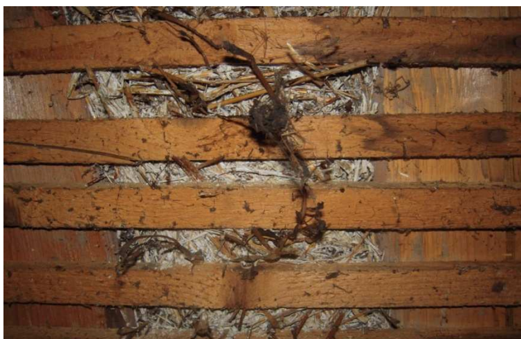
Slika 10: Detajl malte, slame ter prečnih letev
