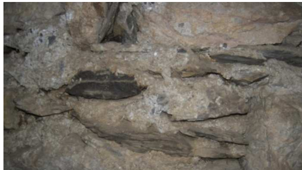
Slika 6: Nearmiran kamniti zid na notranji strani kleti
