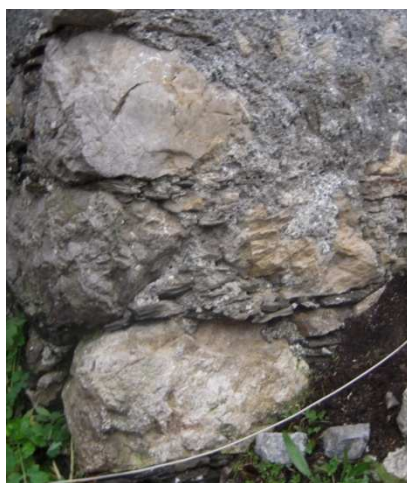
Slika 8: Sestava nearmiranega zidovja na vogalu stavbe – vogelni kamni
