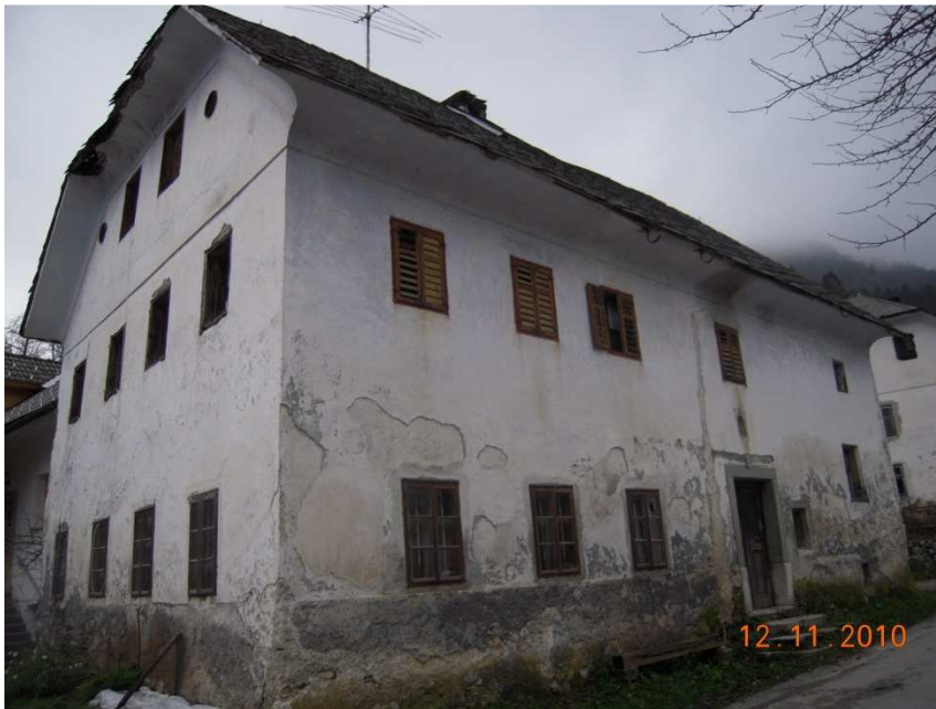
Slika 3: Zunanost obravnavane stavbe
