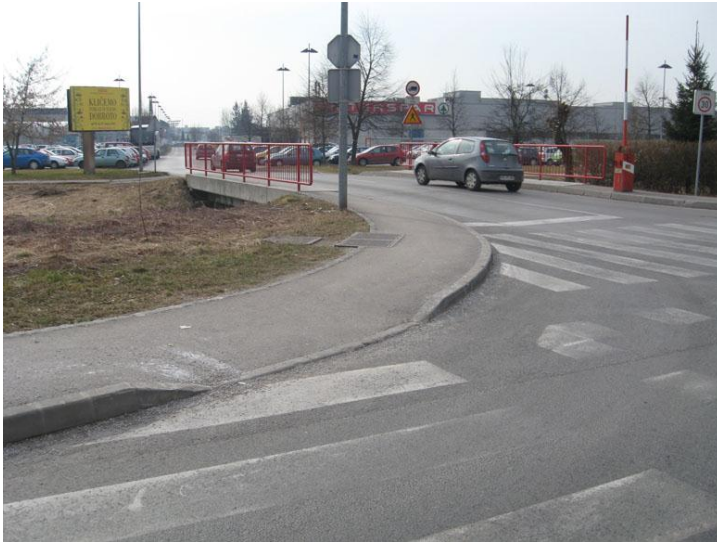
Slika 7: Napačna izvedba vdolbene klančine
