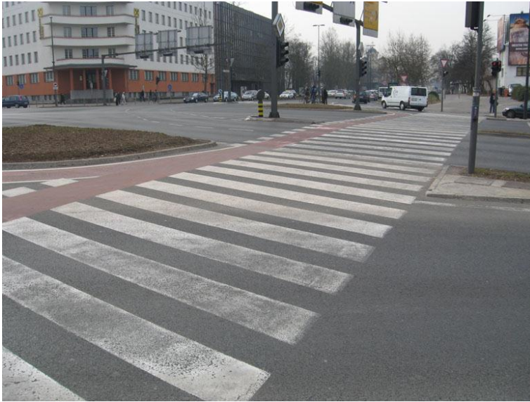
Slika 10: Slaba izvedba križišča z otokom
