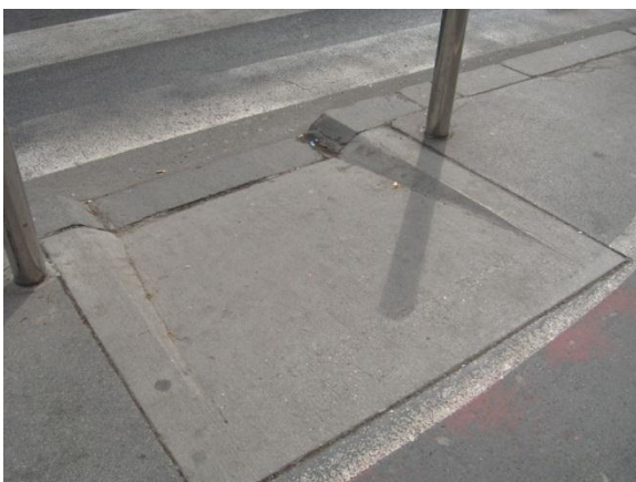
Slika 6: Prefabriciran element na Slovenski cesti
