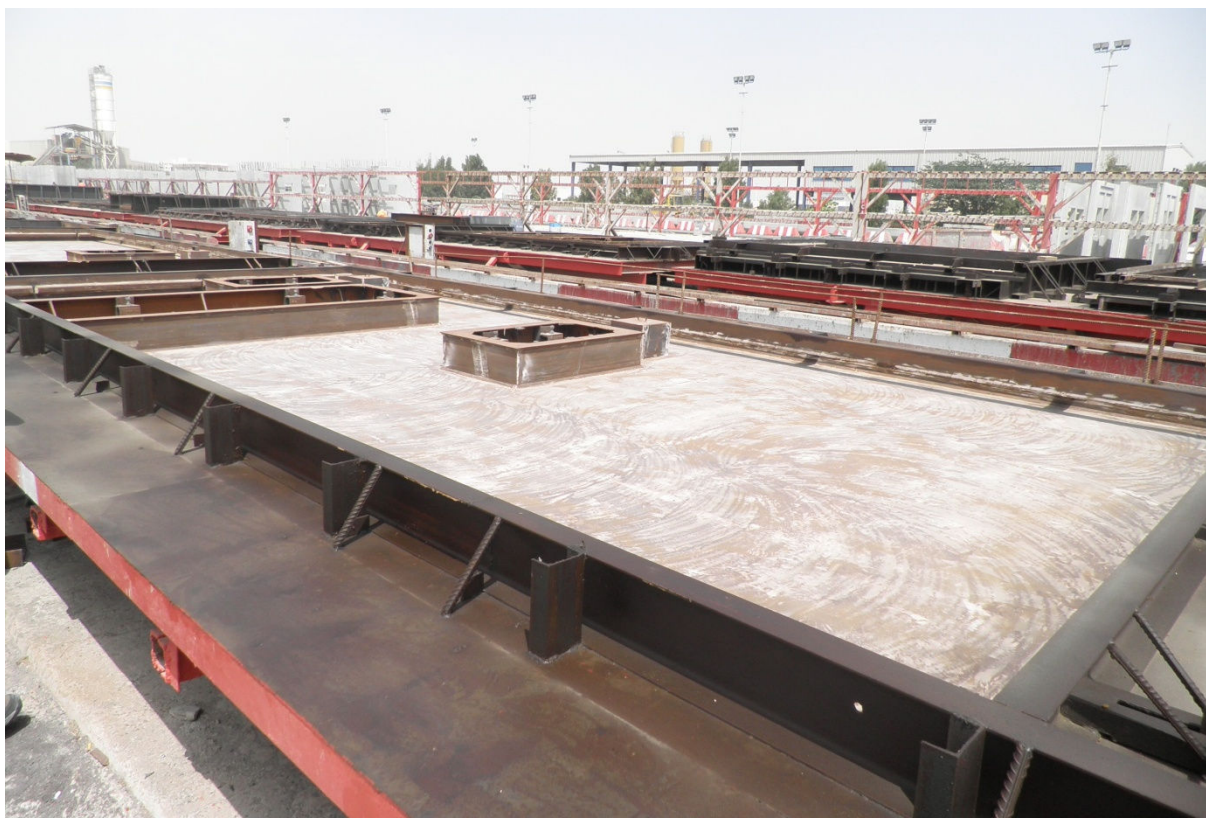
Slika 18: Kalup za izdelavo prefabriciranih stenskih elementov
