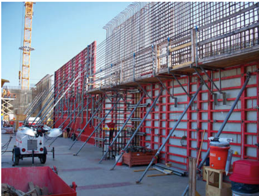
Slika 10: Stenska opažna konstrukcija podjetja Meva 4
