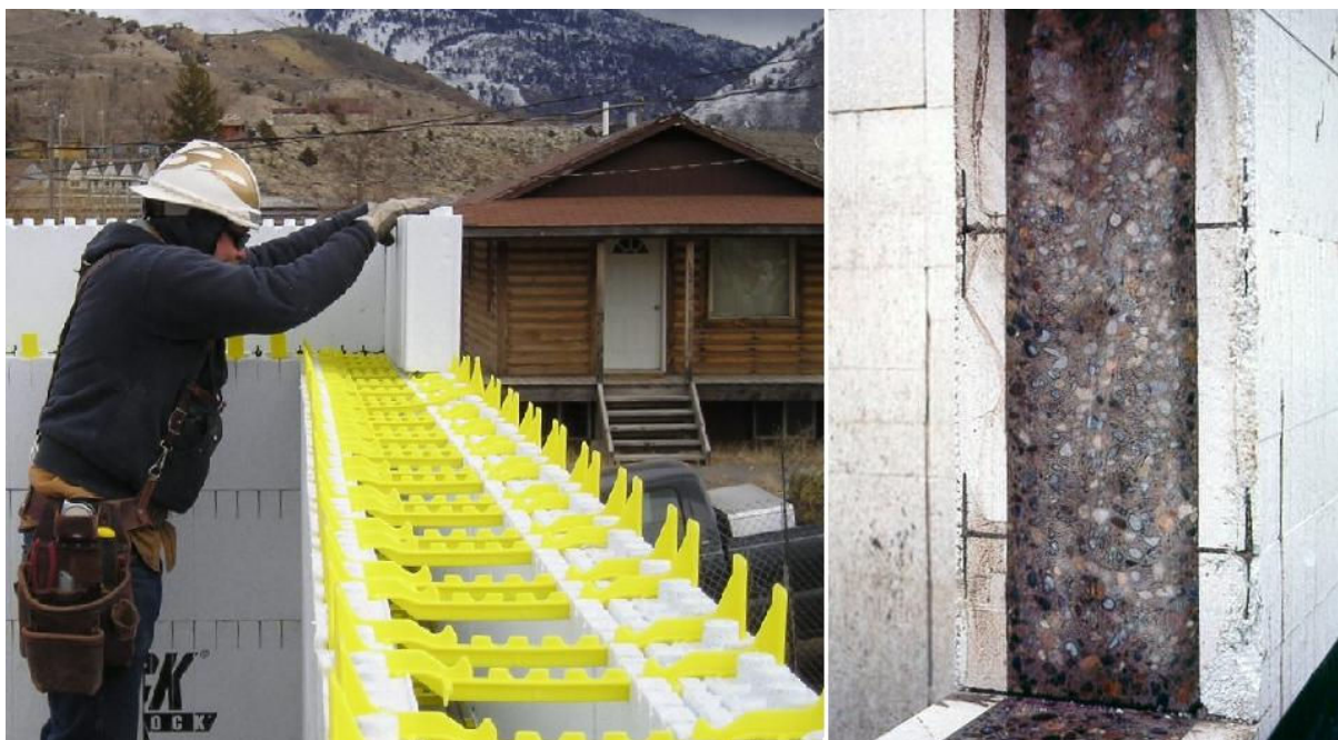
Slika 21: Izolativni izgubljeni opaž podjetja Quad-lock 12
