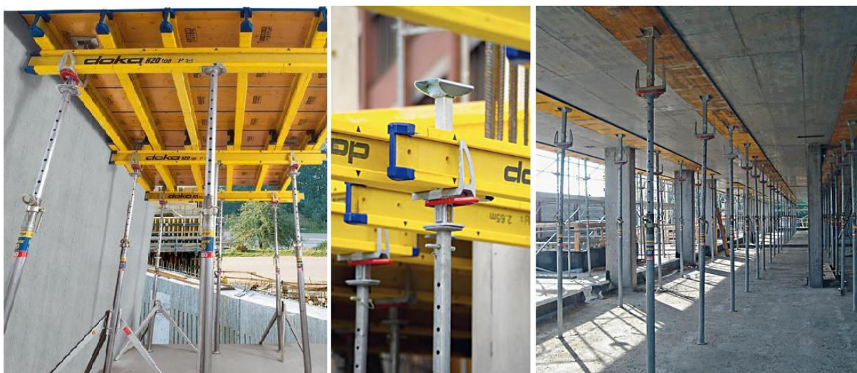
Slika 28: Sistem montaže in demontaže Doka Xtra s pogrezno glavo
