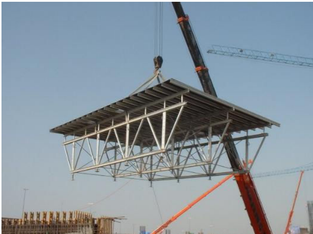
Slika 13: Aluminijasta opažna miza podjetja Aluma Systems 7
