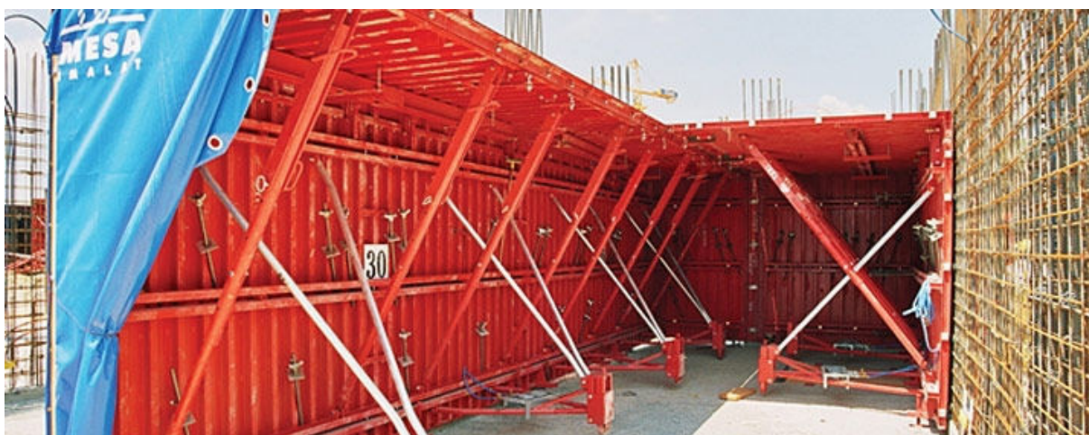
Slika 14: Pravokotna tunelska opažna konstrukcija podjetja Mesa 8
