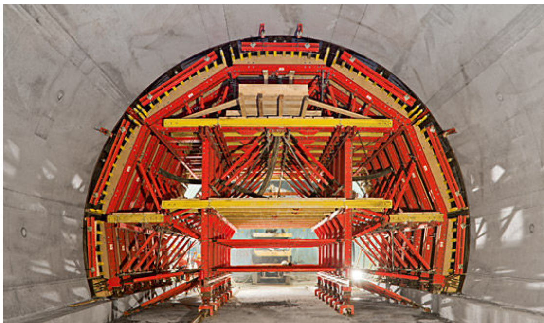
Slika 15: Opaž ukrivljene lupine tunela podjetja Peri 9
