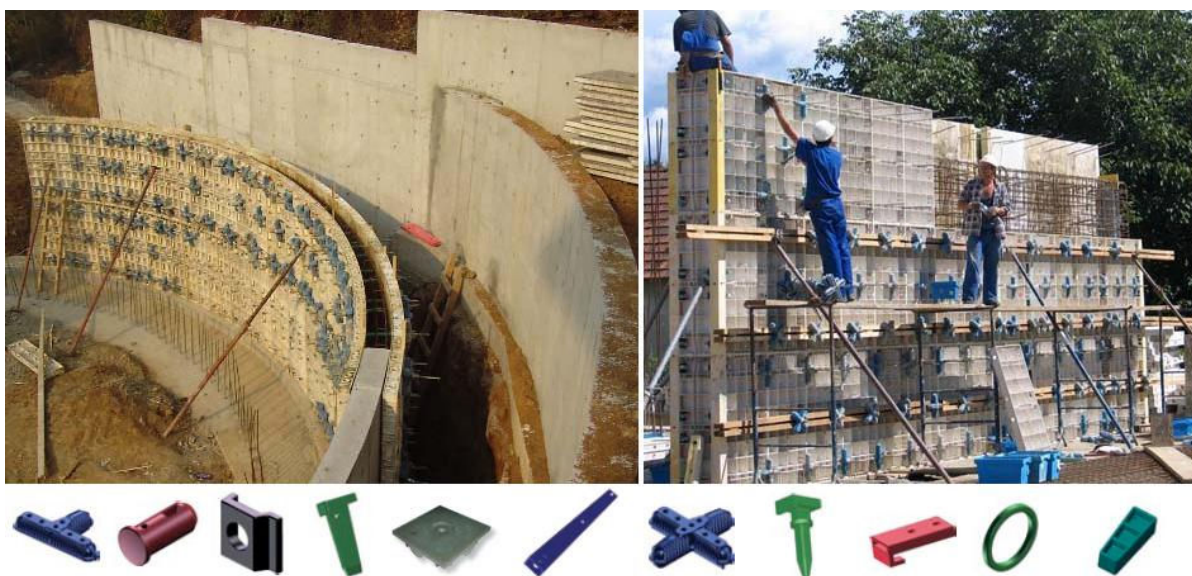
Slika 33: Epic Eco stenski opažni sistemi s pripadajočim veznim materialom 23
