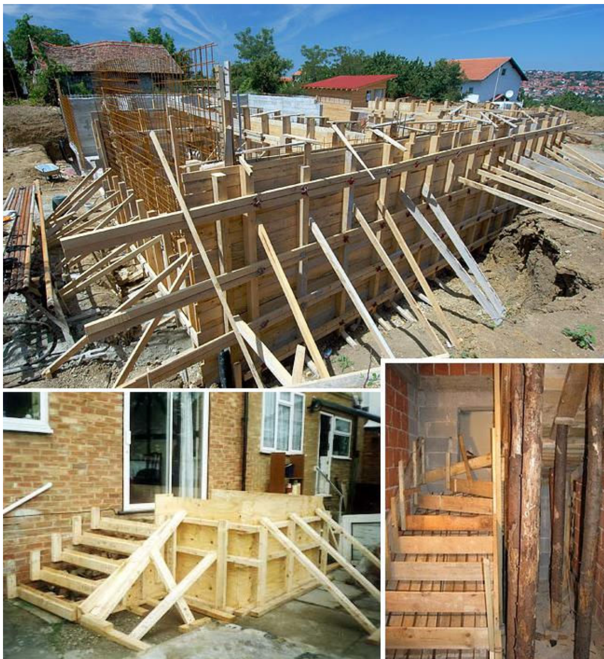
Slika 5: Primeri tradicionalnih opažev
