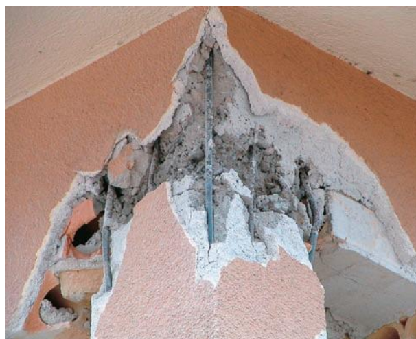
Slika 6: L'Aquila - Armatura stebra (Vir: Cecić, Godec, 2010)
