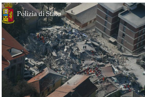
Slika 7: L'Aquila - Porušene in stoječe stavbe (Vir: Polizia di Stato, 2009)
