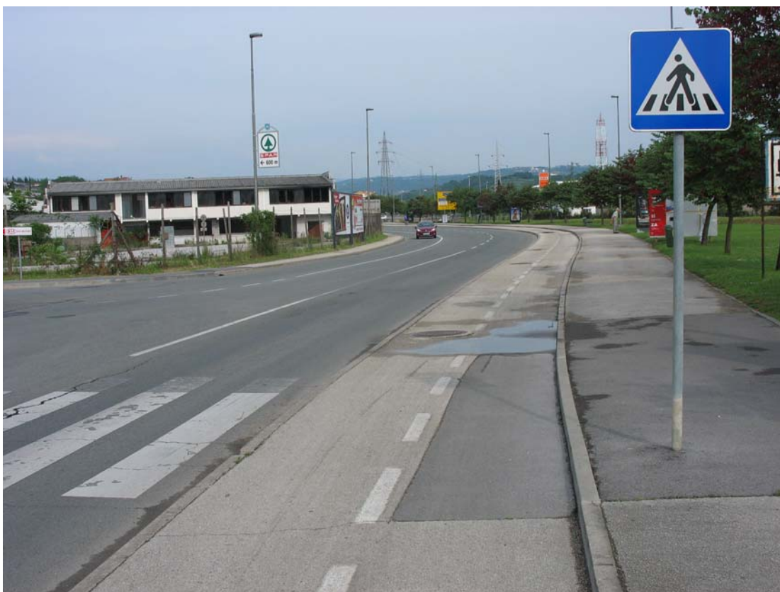
Slika 45: Kolesarska steza nima varovalnega pasu, zgornji ustroj je poškodovan in dotrajan, pojavljajo se številne luže, prehod za pešce je neustrezen
