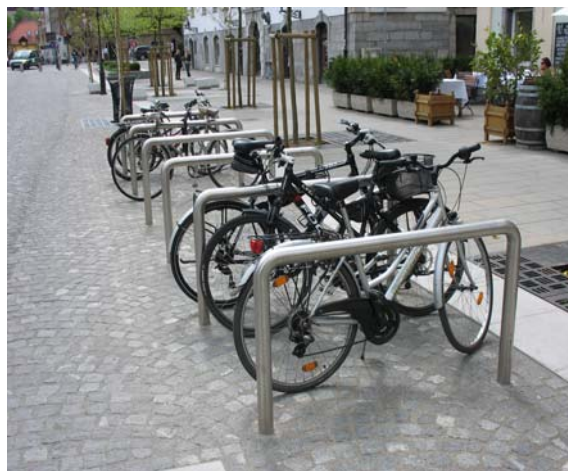
Slika 61: Pravilno izvedena stojala, ki omogočajo zaklepanje okvirja kolesa
