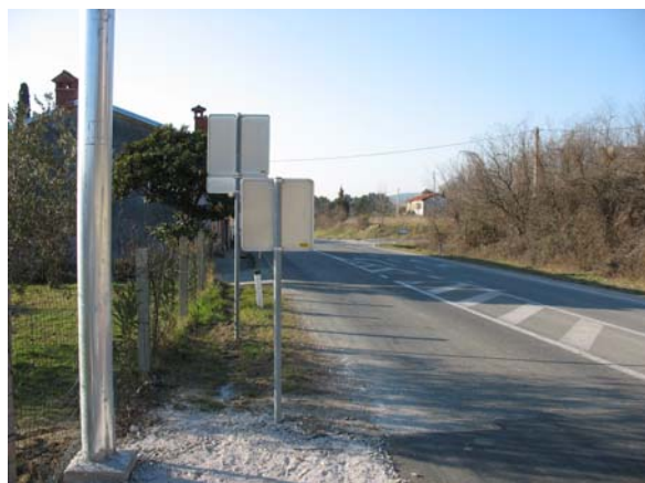
Slika 28: Nerodno postavljena signalizacija kolesarju zastira pogled
