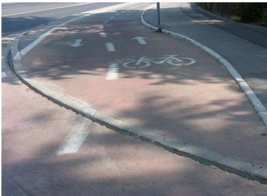
Slika 55: Napačno izveden robnik, ki ni spuščen do roba vozne površine
