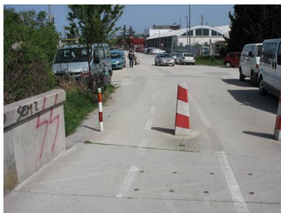
Slika 52: Nepravilno postavljena betonska ovira
