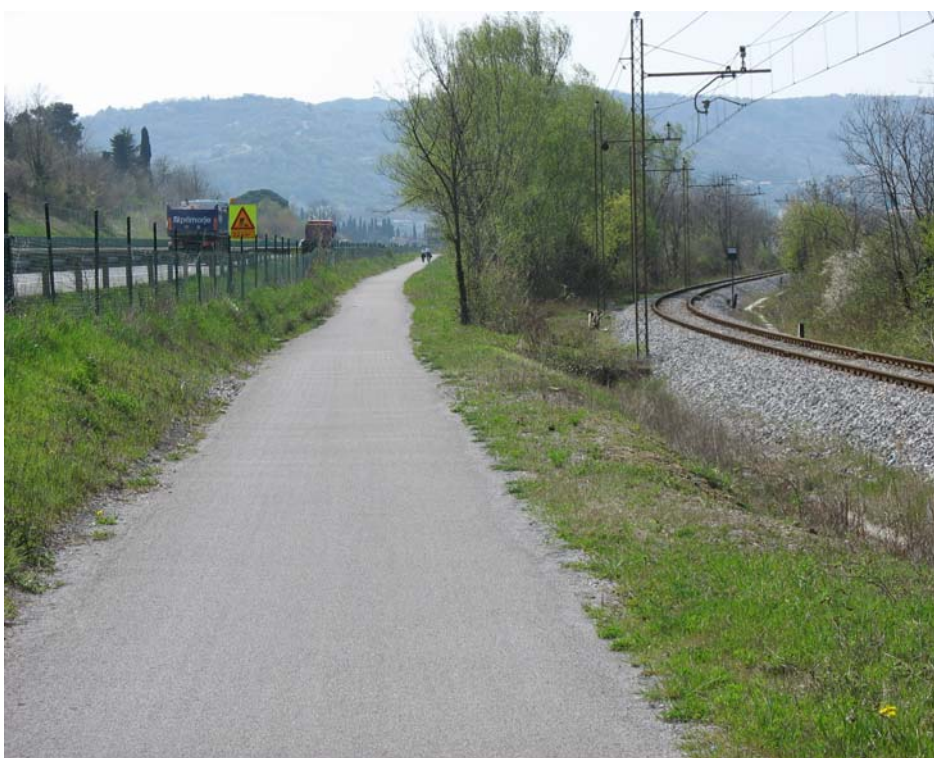
Slika 20: Površinska prevleka na tamponsko podlago ob Škocjanskem zatoku
