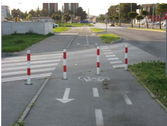
Slika 51: Nepravilno postavljeni jekleni stebrički
