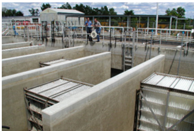
Slika 9: AccuWeb ® modul v reaktorju http://www.brentw.com
