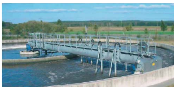
Slika 16: Schreiber bazen in vrtljivi most
