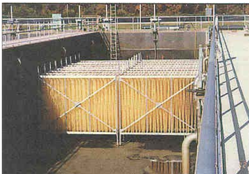
Slika 10: Namestitev RINGLACE® sistema
