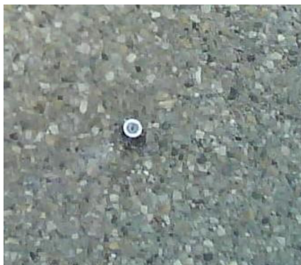
Slika 17: Stabilizacija točke na asfaltu
