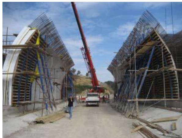
Slika 9: Opaženje sten (Kotnik, 2007)
