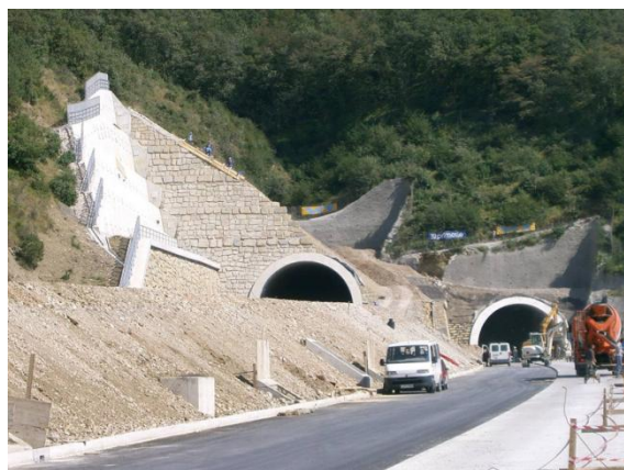
Slika 27: Zahodni portal predora Dekani Vir: http://www.irgo.si
