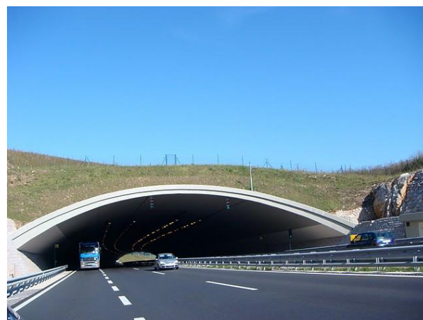
Slika 13: Portal pokritega vkopa Karteljevo Vir: http://picasaweb.google.com/Jovan.Cukut1
