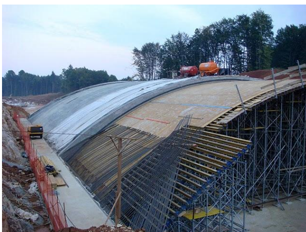
Slika 12: Podporni opaž oboka Vir: http://picasaweb.google.com/Jovan.Cukut1
