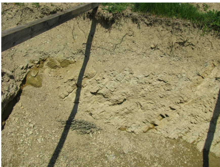
Slika 44: Fotografija severne stranice odprtega izkopa (IZD-1)
