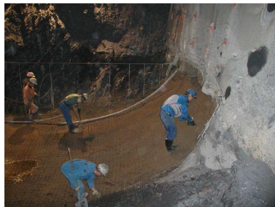
Slika 25: Podporni ukrepi pri gradnji predora Trojane (Likar, 2010) Slika 26: Izdelava talnega oboka (Likar, 2010)
