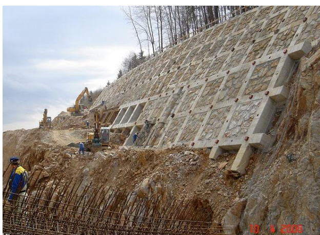
Slika 3: Faznost izkopa sidrano varovanega vkopa Vir: http://picasaweb.google.com/Jovan.Cukut1
