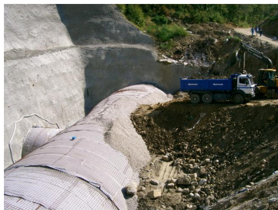
Slika 28: Pokriti vkop je bil po končani gradnji zakrit Vir: http://www.irgo.si
