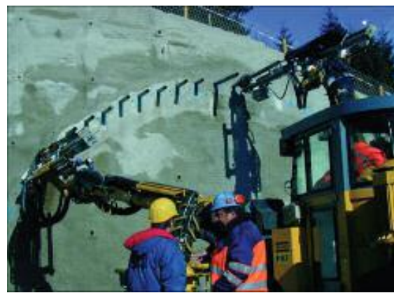
Slika 21: Jekleni cevni ščit Vir: http://www.dywidag.com/products/tunneling
