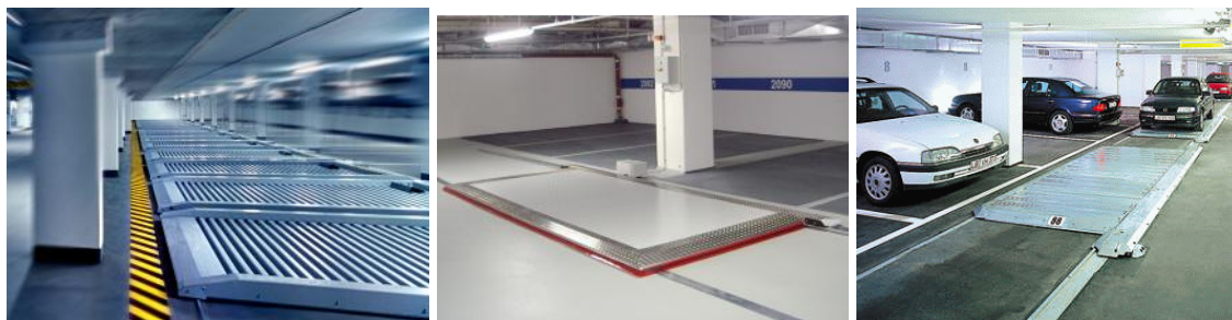
Primeri drsnih ploščadi, Vir: www.nussbaum-parking.de (2010)
