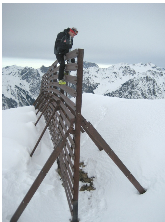
Slika 23: Snežni plotovi prerazporejajo sneg, ki ga prenaša veter. (foto: Procter, 2008)
