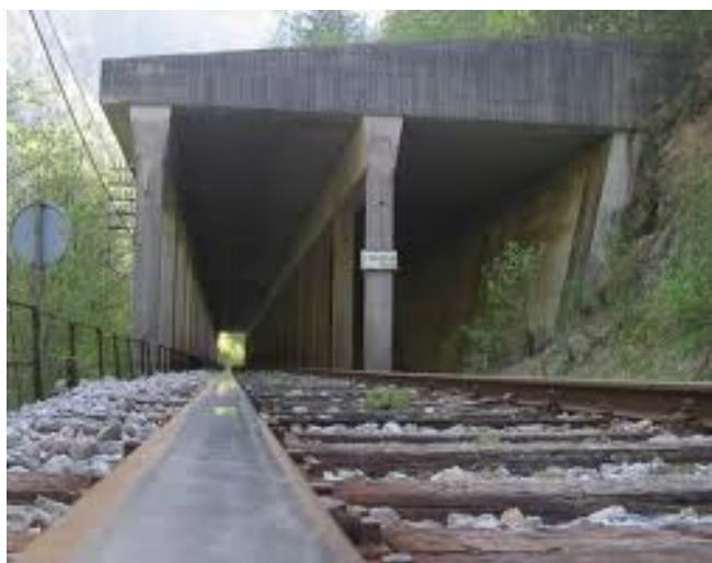
Slika 24: Lavinska galerija na železniški progi Jesenice – Bohinjska Bistrica v Soteski.
