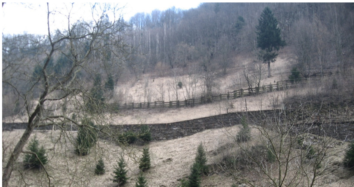
Slika 36: Palisade zaustavljajo padec kamenja in preprečujejo zdrs plazov (foto: Sirk, 2011).
