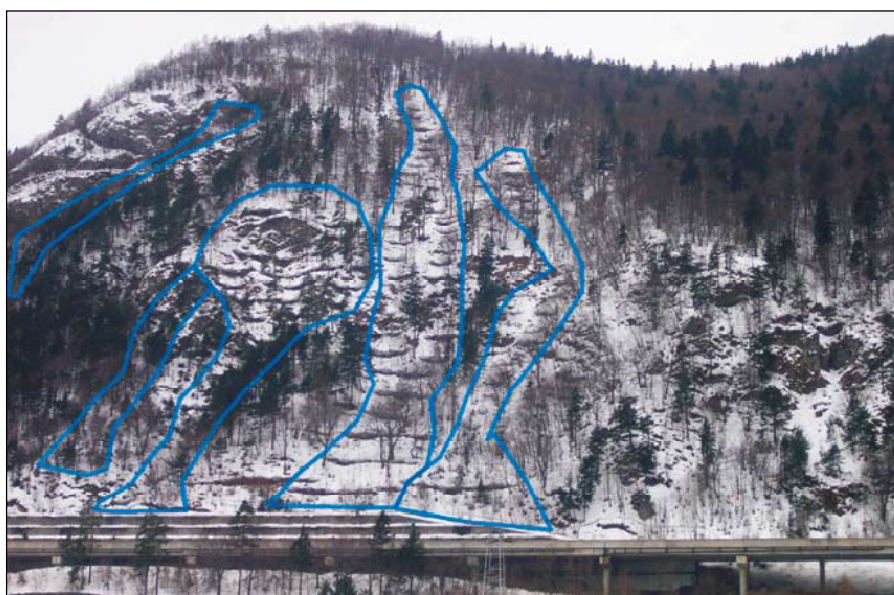
Slika 28: Štiri plazne drče na pobočju Mežakle, na katerih je bila izvedena protiplazovna zaščita.
