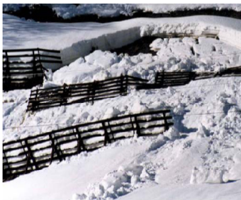
Slika 20: Zasuti snežni mostovi ne morejo več preprečevati zdrsa snega.
