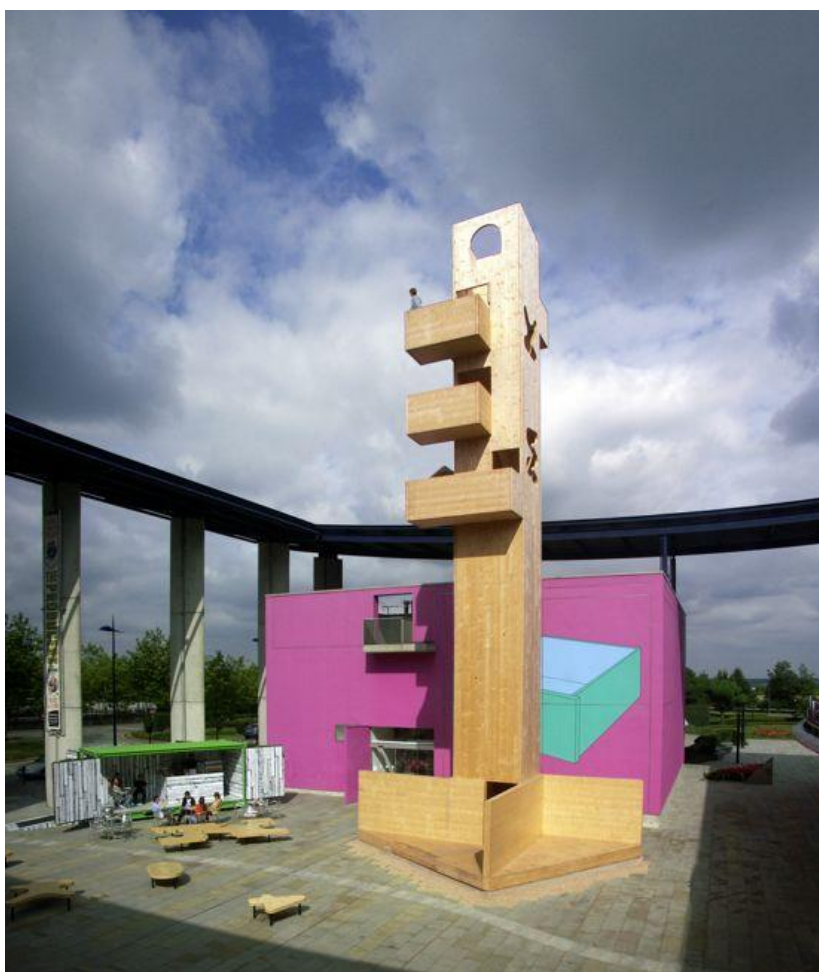
Slika 2: Ob 40. letnici mesta Milton Keynes v Veliki Britaniji so postavili začasen razgledni stolp, ki je v višino meril skoraj 20 metrov in ni potreboval temeljenja (vir: http://www.scottisharchitecture.com/uploads/Image/alexderijke/MK40_ph_tower06_42x50_72dpi_AdR.jpg )
