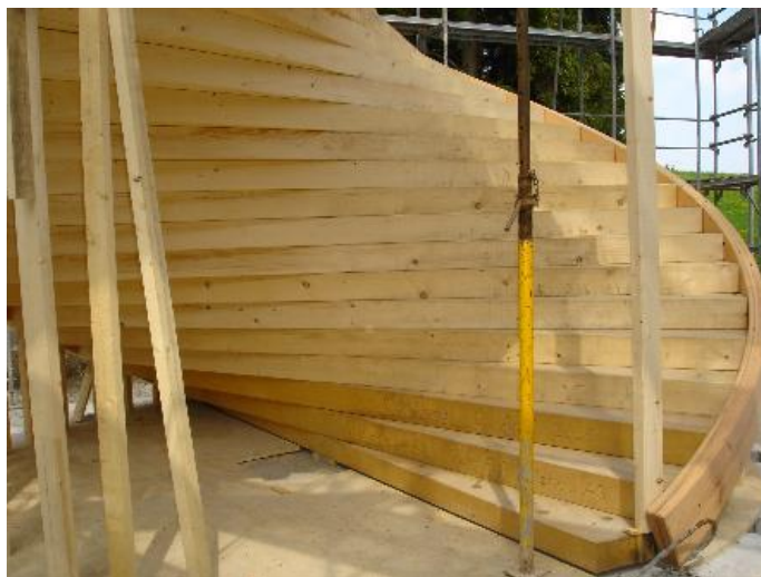
Slika 13: Stopnišče med gradnjo
