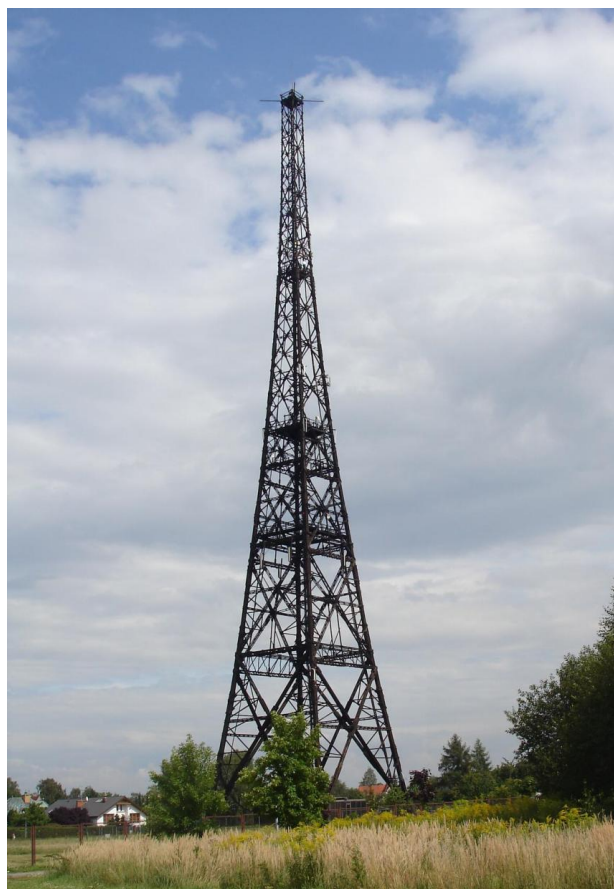
Slika 4: Radijski stolp Glivice je s 118 metri najvišja obstoječa lesena konstrukcija na svetu (vir: http://upload.wikimedia.org/wikipedia/de/6/68/DSC04041.JPG )
