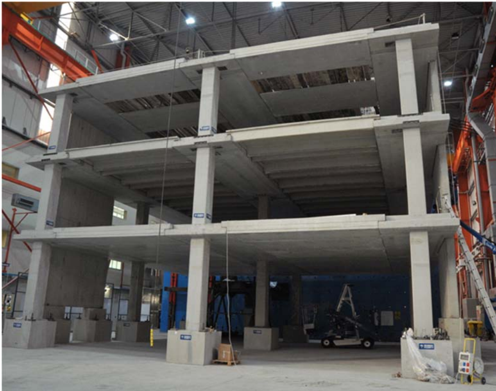
Slika 2: Preizkušana trietažna montažna stavba, ki se v naravnem merilu psevdodinamično preizkuša v evropskem laboratoriju za preizkušanje konstrukcij ELSA v Ispri v Italiji.
