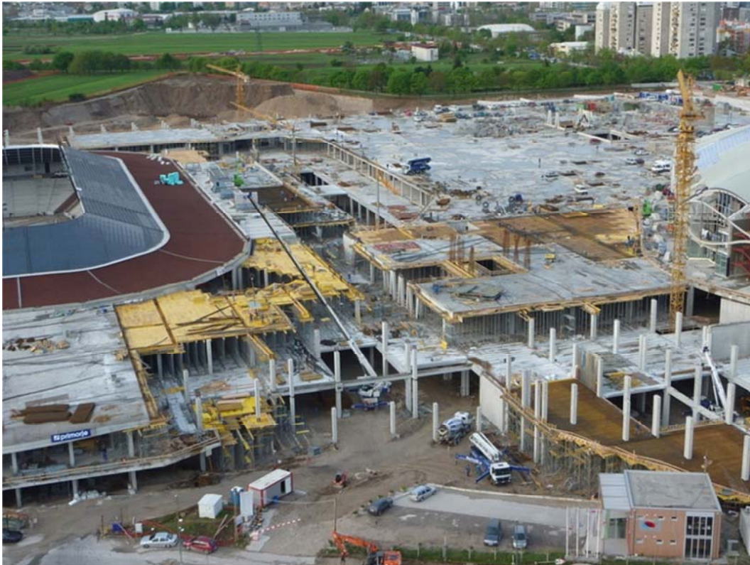
Slika 1: Gradbišče trgovskega centra in podzemnih garaž v Stožičah (za sliko se zahvaljujemo gradbenemu podjetju Primorje iz Ajdovščine)
