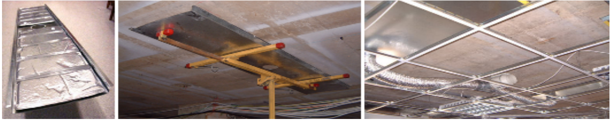
Slika 25: Spuščen strop s sistemom Cooldeck PCM podjetja Climator [22]
