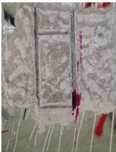
Slika 5: Destruktivna preiskava; iskanje količine in razporeditev armature (Dolinšek, 2010: str. 8)
