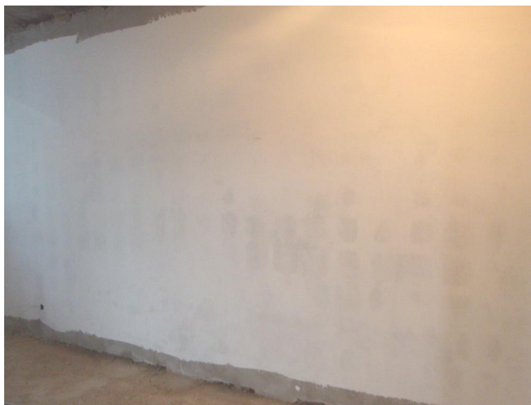
Slika 21: Vidni robovi porušenih obstoječih ploščic tudi po kitanju
