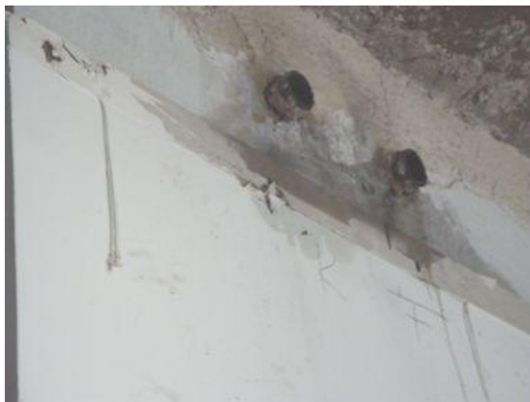
Slika 19: Primer napake strojnih inštalaterjev
