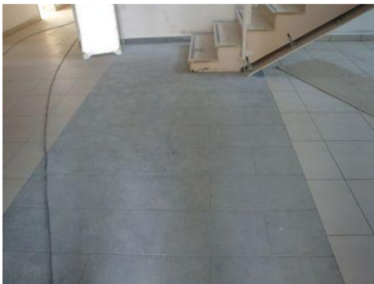
Slika 15: Izbrane keramične ploščice v hodniku
