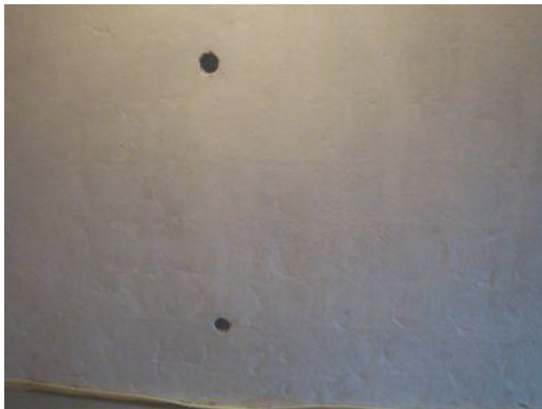
Slika 20: Vidni robovi porušenih obstoječih ploščic kljub izravnavi
