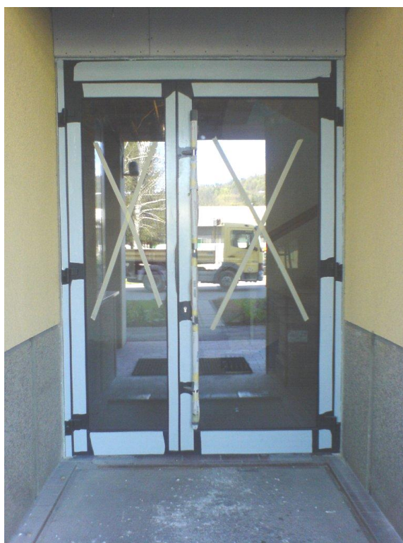
Slika 14: Končna oblika vgrajenih vrat ročnega odpiranja
