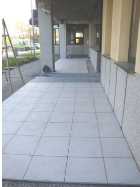
Slika 18: Položene nove keramične ploščice preko obstoječih
