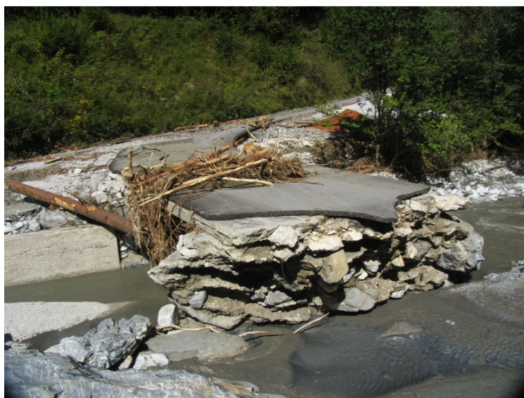
Slika 37: Porušena premostitev v srednjem toku Davščice (foto: Mikoš, 22. 9. 2007)
