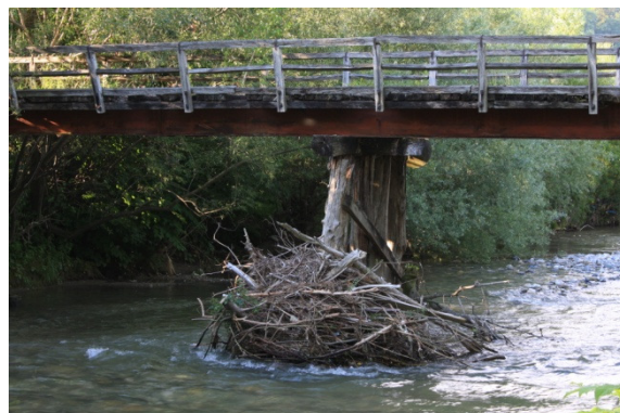
Foto 4: Na brvi na Meži nakopičeno plavje pribl. 1 km gorvodno od Kovtrovega mostu - dokaz o premeščanju plavja
