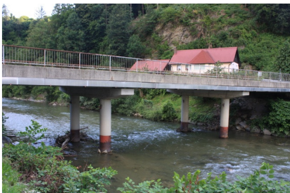
Foto 3: Meža pri Dravogradu - na stebrih opazimo sledi plavja
