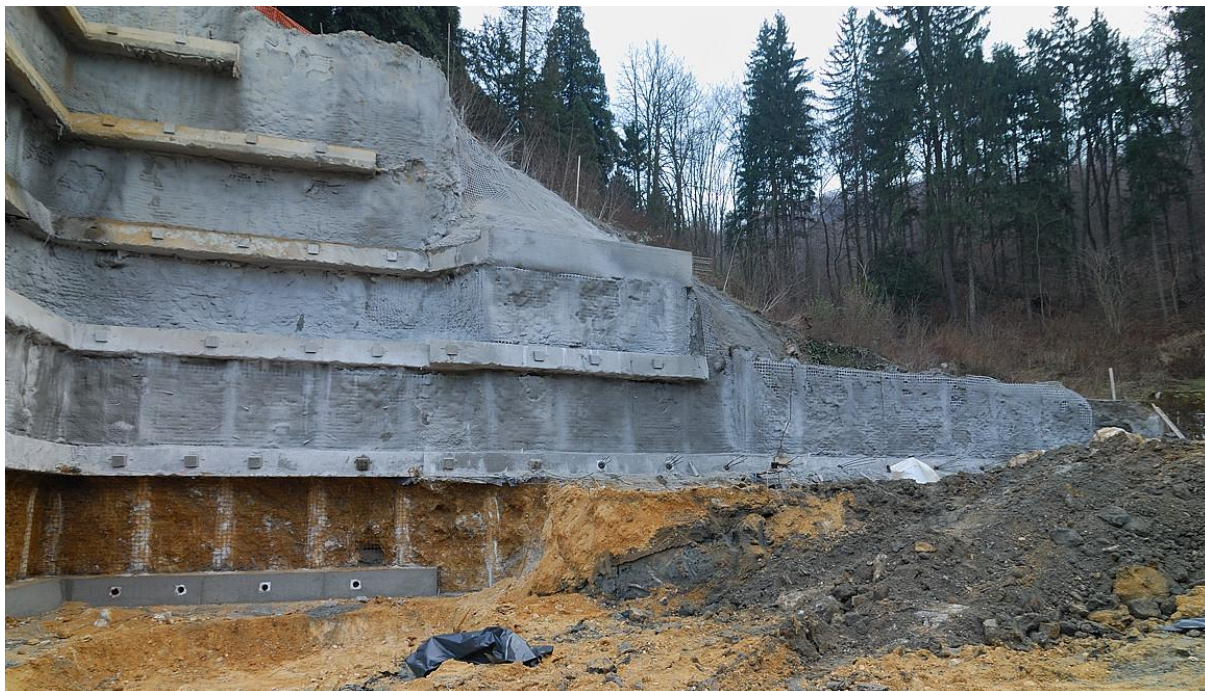
Slika 4: Sidrana pilotna stena na južnem delu gradbene jame
