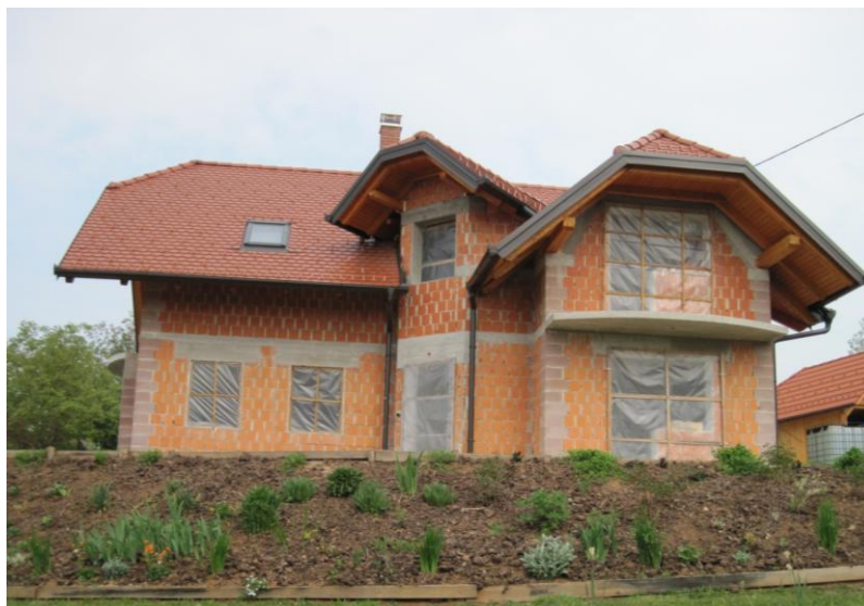
Slika 14: Novogradnja - stanovanjska hiša
