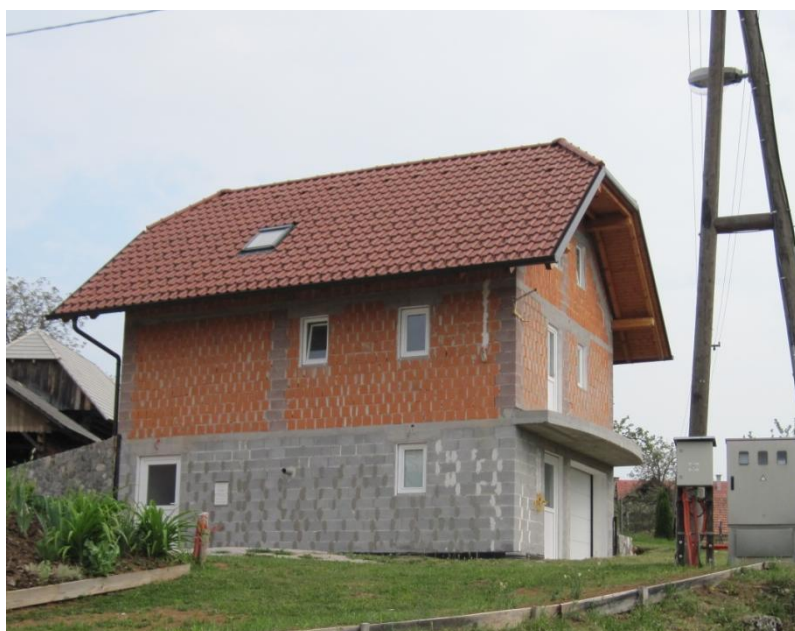
Slika 15: Novogradnja – stanovanjska hiša
