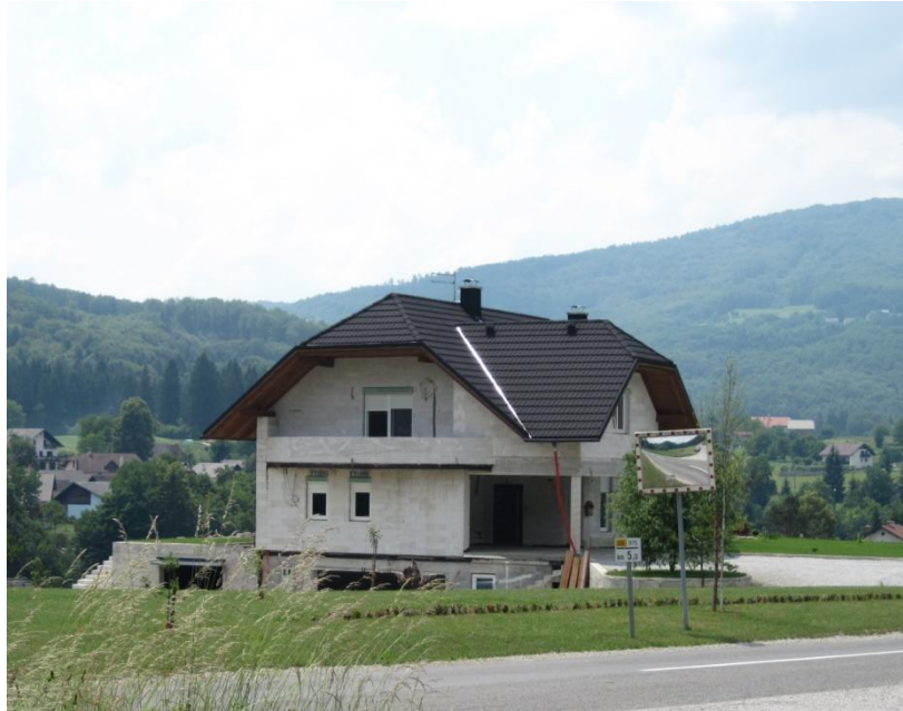
Slika 16: Novogradnja – stanovanjska hiša
