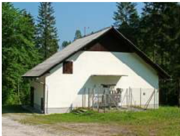
Zgradba strojnice mHE Mesto (SENG: mHE)
