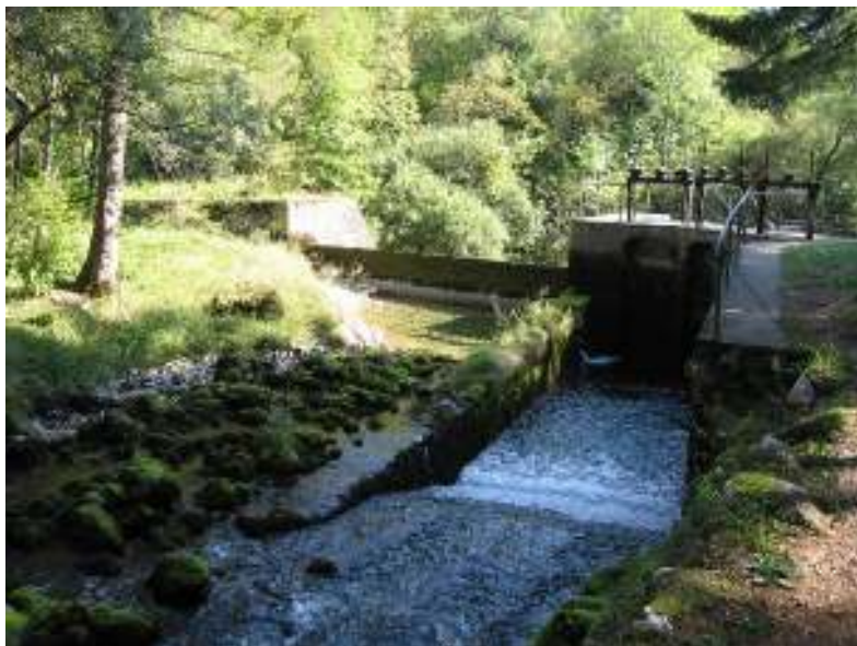
Odvzem vode na vodotoku Gljun – mHE Plužna (SENG: mHE)
