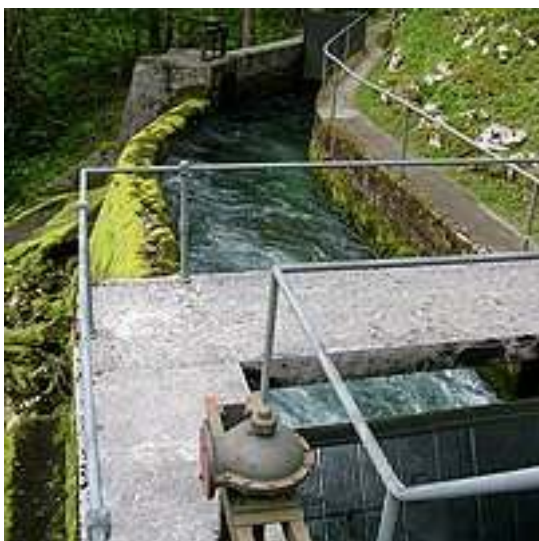
Dovodni kanal in zapornice mHE Plužna (SENG: mHE)
