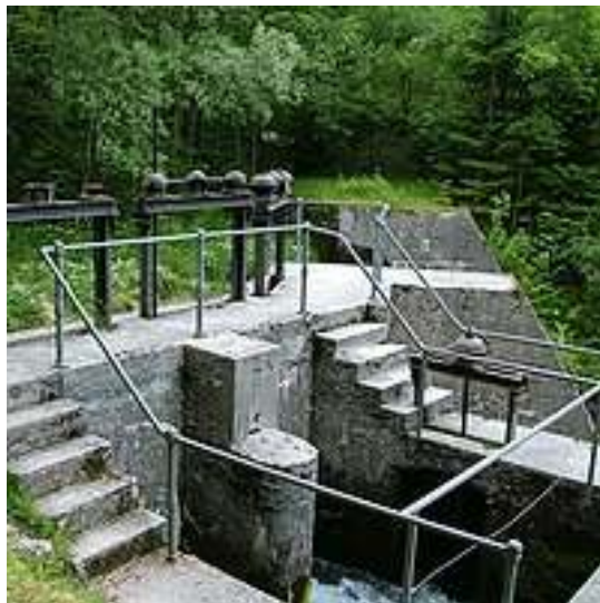
Dovodni kanal in zapornice mHE Plužna (SENG: mHE)
