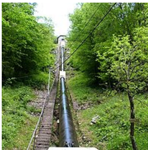
Akumulacijski bazen in dovodni cevovod mHE Plužna (SENG: mHE)
