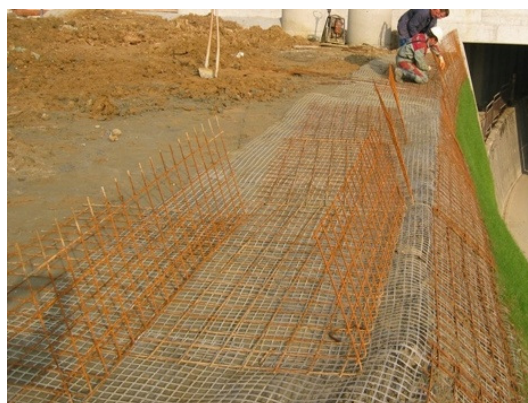
Slika 30: Kovinska armaturna mreža, krivljena pod določenim kotom.
