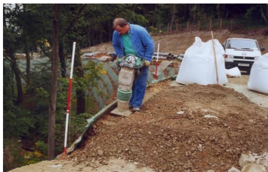
Slika 25: Primer vgradnje sloja humusa.
