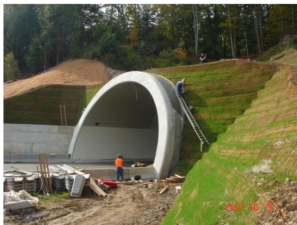
Slika 19: Primer izvedbe armirane brežine z zatravljenim čelom.
