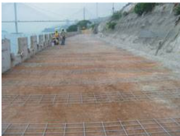
Slika 13: Primer uporabe jeklenih trakov.
