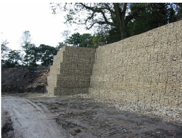
Slika 37: Podporni zid iz kamnitih gabionov.
