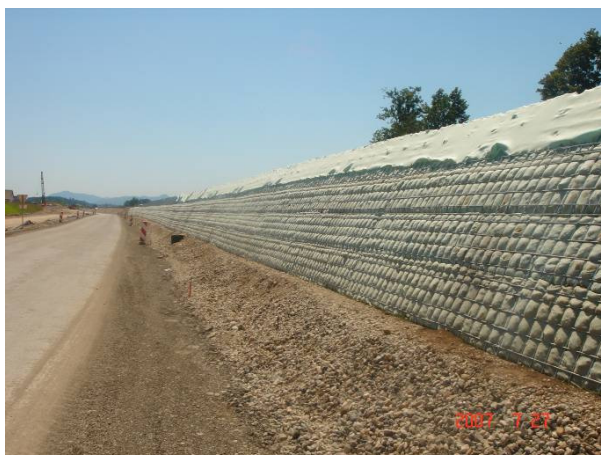
Slika 44: Brežina po sistemu armirane zemljine v času gradnje.
