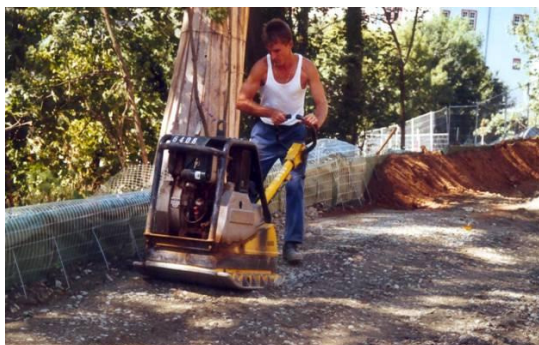
Slika 24: Primer vgradnje sloja humusa.
