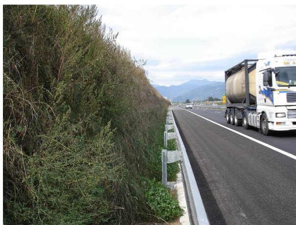
Slika 45: Brežina po sistemu armirane zemljine po izvedbi.
