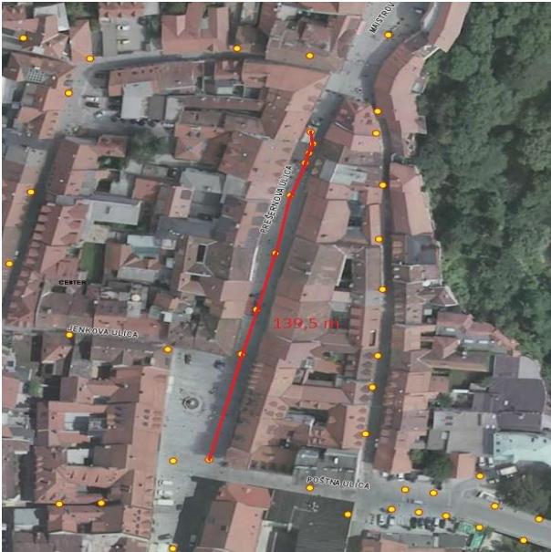
Slika 19: Kabelska kanalizacija na Glavnem trgu (iObčina)
