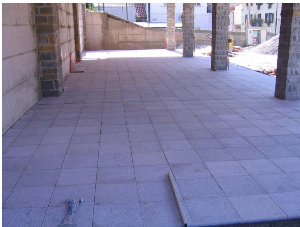
Slika 40: Položene granitne plošče
