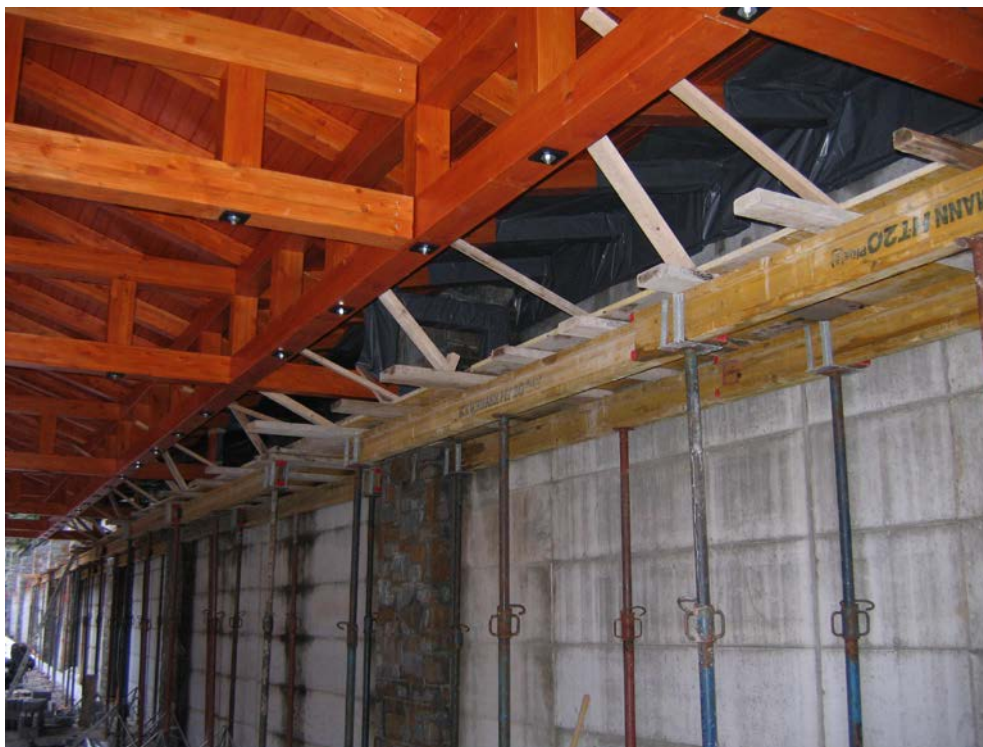
Slika 39: Izdelava vencev med slopi
