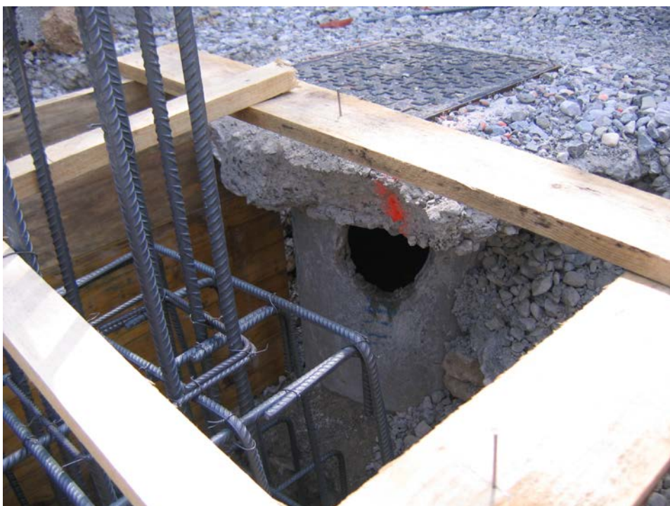
Slika 34: Izkop ter opažanje temelja in obstoječa kanalizacija
