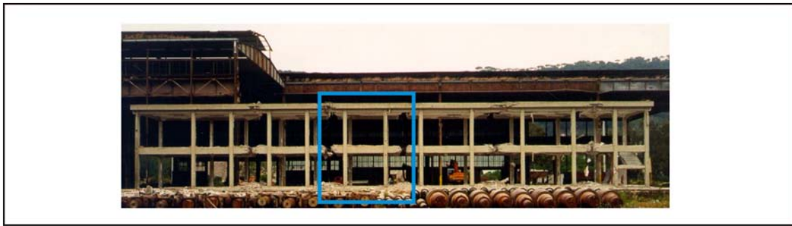
Slika 6.5: Fotografija celotne konstrukcija z označenim analiziranim delom. Figure 6.5: Photography of the entire structure. The analysed section is framed.
