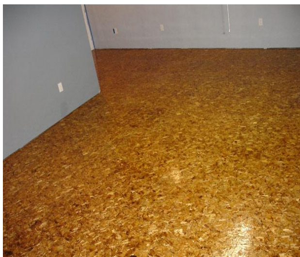
Slika 2.18: Uporaba iverne plošče z usmerjenim iverjem kot talna obloga ( http://livemodern.com/ )
