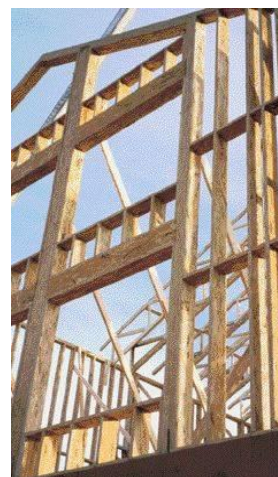
Slika 2.10: Konstrukcija iz PSL elementov ( www.structuremag.org )
