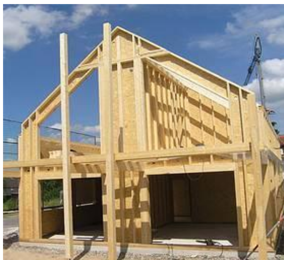
Slika 2.25: Primer uporabe DUO in TRIO nosilcev
