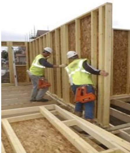
Slika 2.17: Uporaba ivernih plošč z usmerjenim iverjem za predelne stene ( http://www.norbord.com/images/OSB3.jpg )
