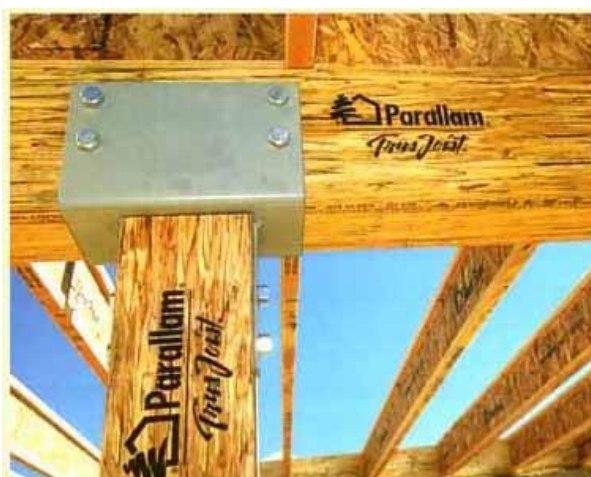
Slika 2.9: Primer stika PSL elementov ( www.big-creek.com )
