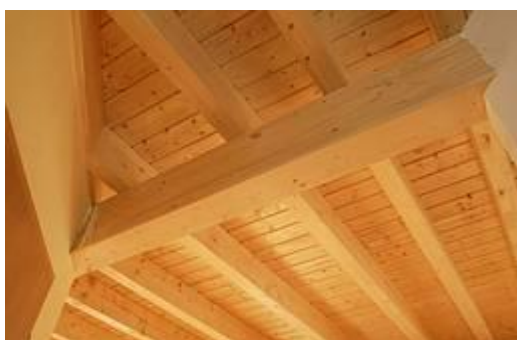
Slika 2.26: Detajl ostrešja iz DUO oziroma TRIO nosilcev
