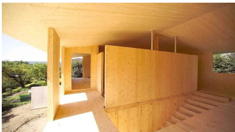
Slika 2.29: Notranjost stanovanjske stavbe iz CLT med gradnjo
