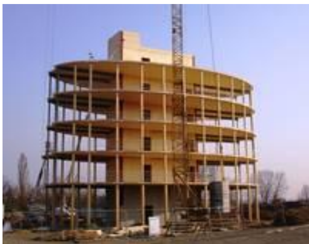
Slika 2.30: Poslovni objekt iz CLT med gradnjo ( http://www.klh.at/ )
