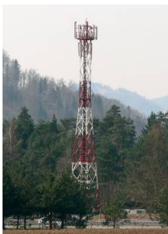
Slika 2-3: Sprejemno oddajna enota bazne postaje
