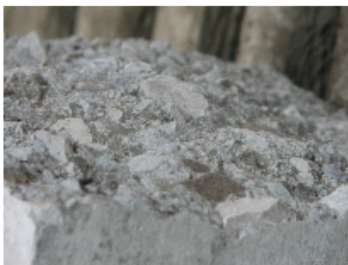
Slika 5.9: Izgled grobo hrapave površine starega podložnega betona.
