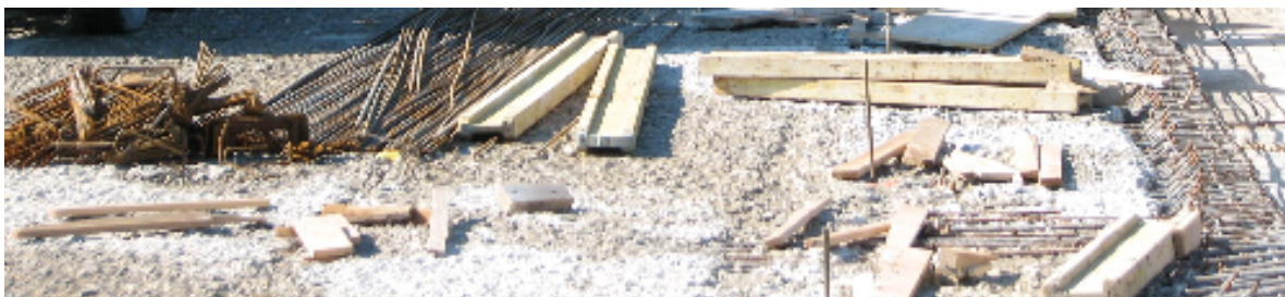
Slika 2.1: Površina betona po odstranitvi poškodovanega sloja.
