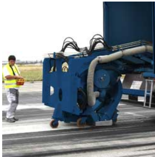
Slika 2.2: Primer opreme za peskanje z jeklenimi kroglicami.
