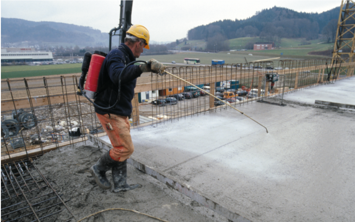
Slika 2.4: Nega s sredstvom za nego betona.
