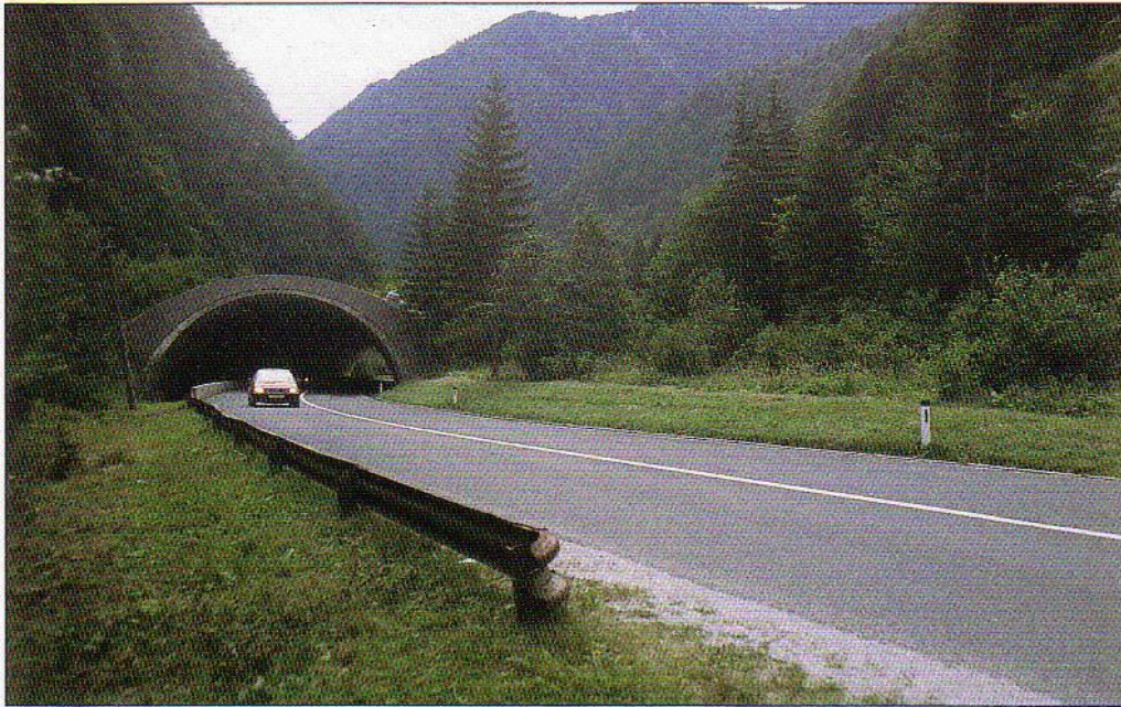
Slika 60. Trajno zavarovanje magistralne ceste Tržič-Ljubelj z lavinskim predorom
