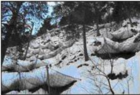
Slika 62. Na sliki so prikazane snežne mreže
