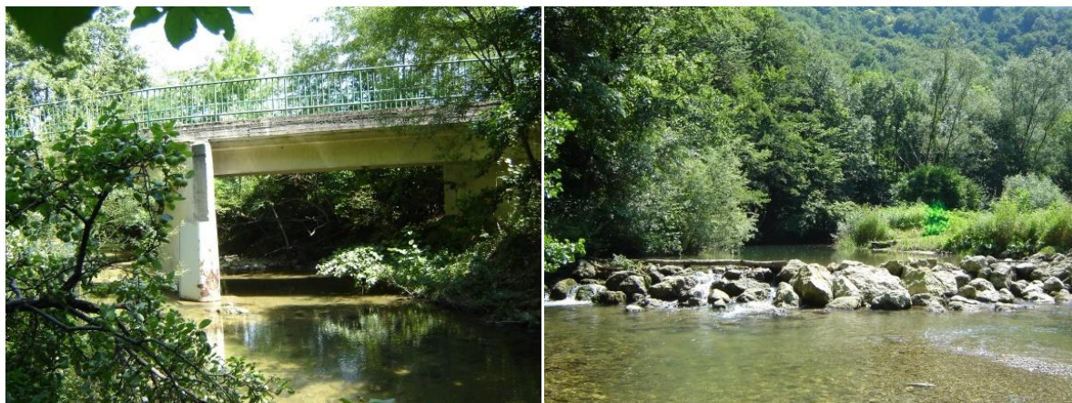
Slika 20 in Slika 21: Na levi sliki je cestni most, ki se nahaja približno 50 m dolvodno ter na desni sliki prelivni jez približno 80 m gorvodno od vodomerne postaje Zagaj I
