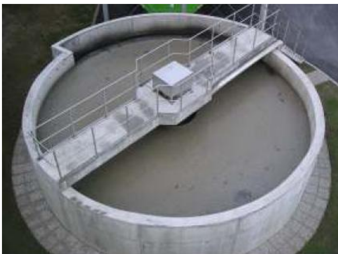
Slika 36: Predzgoščevalnik blata (Naveršnik, 2006)
