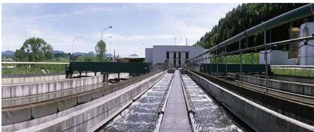
Slika 29: Linija mehanskega čiščenja (Naveršnik, 2006)
