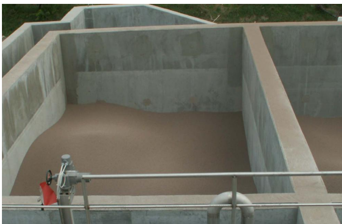
Slika 31: Nosilni material – glineni delci v biofiltrih (Pipuš, 2007)
