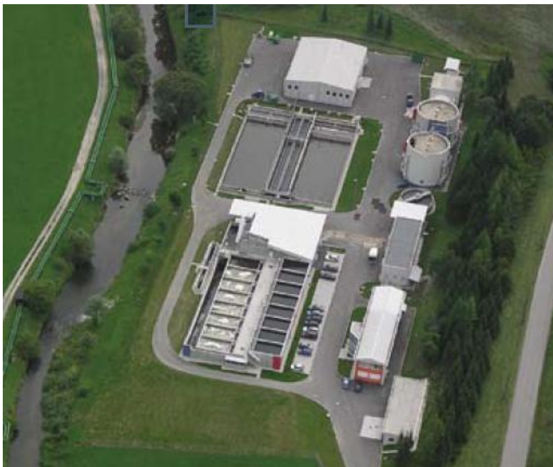
Slika 28: Slika iz zraka CČN Šaleške doline po izgradnji II. faze (Naveršnik, 2007)
