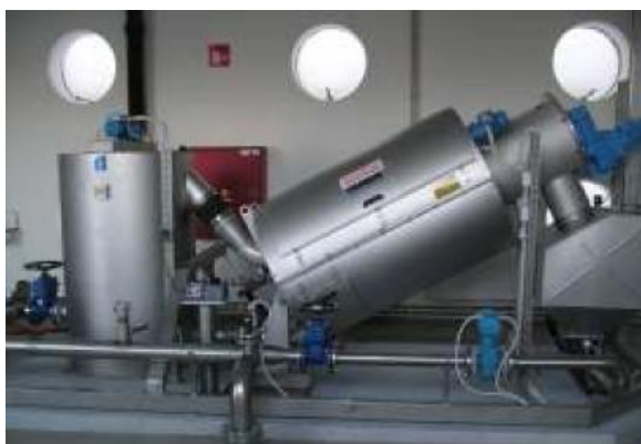
Slika 38: Zgoščevalnik blata (Naveršnik, 2006)
