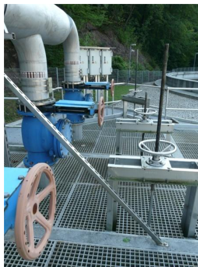
Slika 55: Črpalke na razdelilnem objektu
