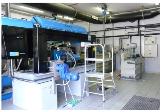
Slika 63: Del linije obdelave blata – centrifuga
