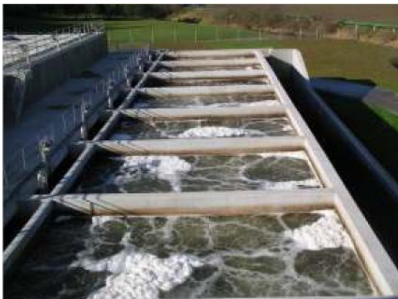
Slika 30: Biološko čiščenje - biofiltri (Naveršnik, 2006)
