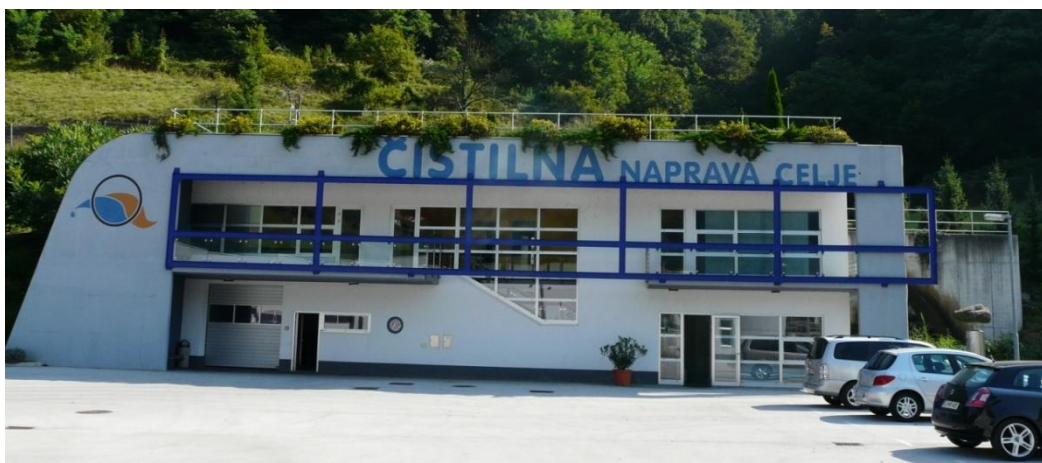
Slika 44: Upravna stavba CČN Celje
