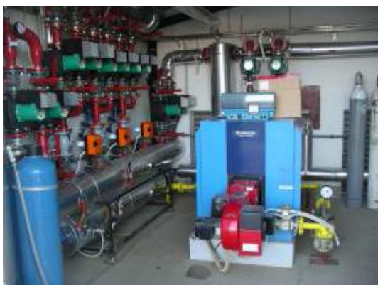
Slika 40: Izraba gniliščnega plina (Naveršnik, 2006)
