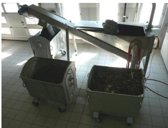
Slika 47: Odpadki grabelj v kolesnem zabojniku
