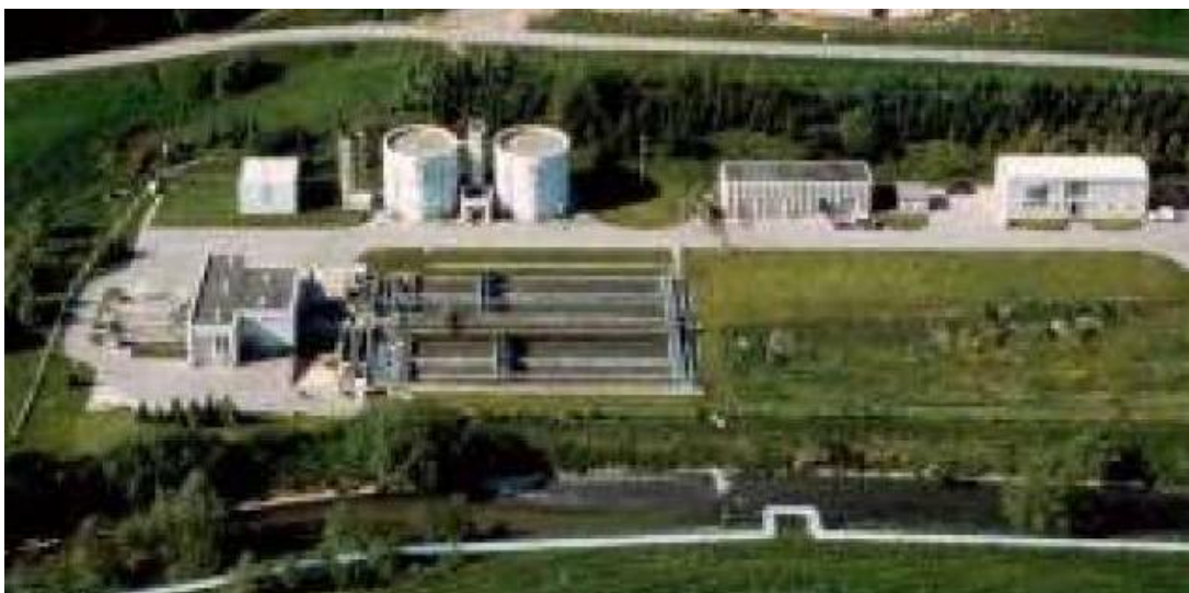
Slika 27: Slika iz zraka CČN Šaleške doline pred izgradnjo II. faze (Šterbenk, 1997)
