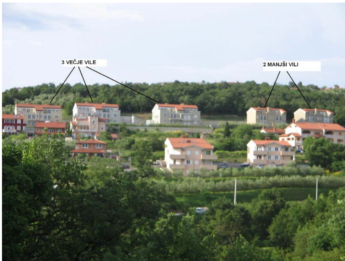
Slika 1: Obstoječi objekti tipa A
