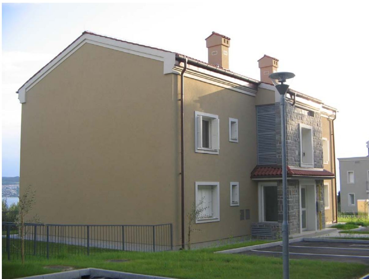
Slika 5: Objekt tipa A2, vzhodna stran
