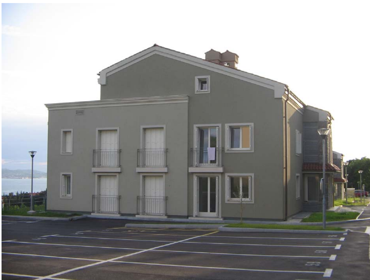
Slika 3: Objekt tipa A1, vzhodna stran
