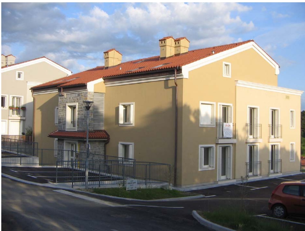
Slika 2: Objekt tipa A1, zahodna stran
