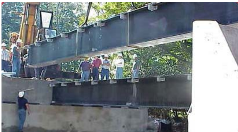
Slika 5.4 Pogled na nosilce med izgradnjo.
