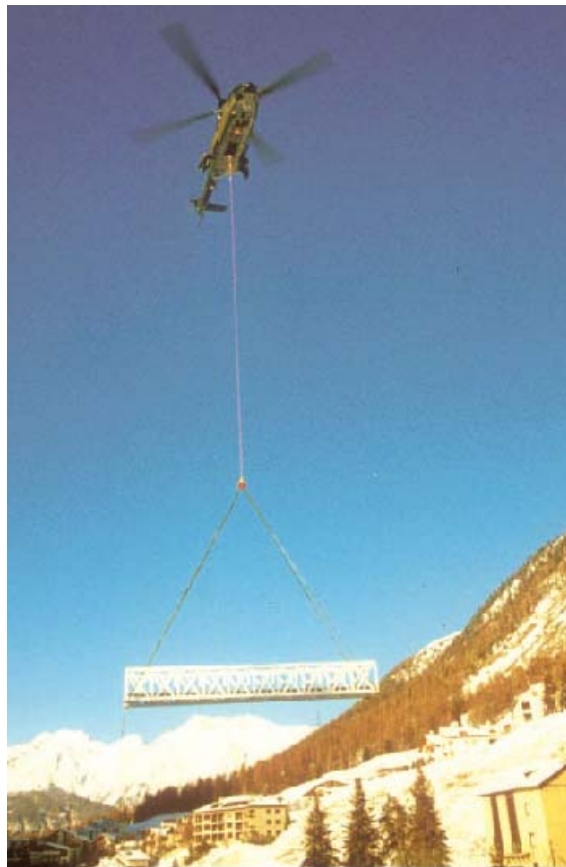
Slika 5.10 Helikopter, ki pozicionira mostno konstrukcijo na podpore (za to opravilo potrebuje le 1,5h).
