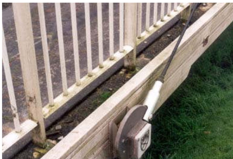
Slika 5.2 Pogled na detajle pritrditve napenjalnega kabla in zaščitne ograje na krovno ploščo.
