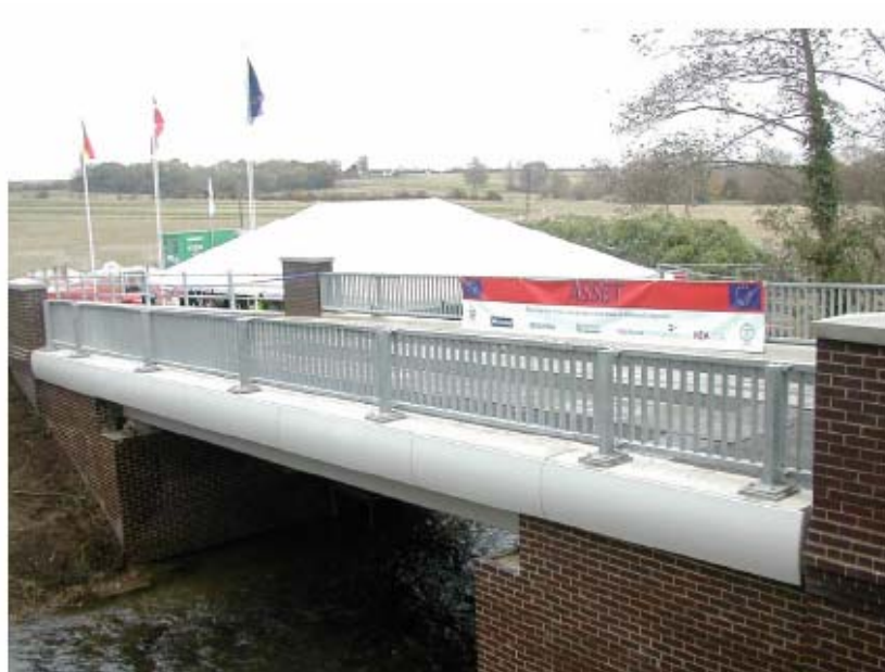
Slika 5.13 Pogled na dokončan most.
