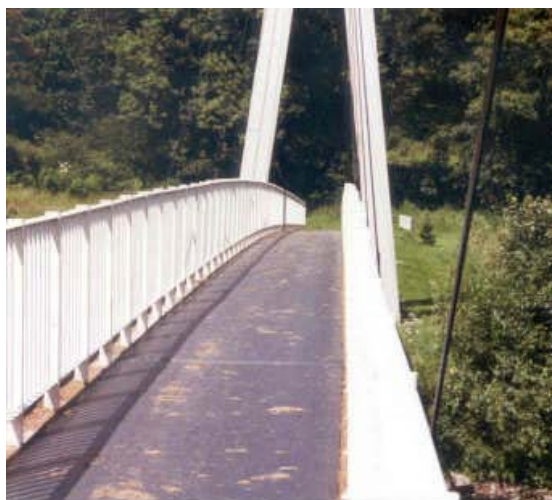
Slika 5.1 Pogled na krovno ploščo mostu.
