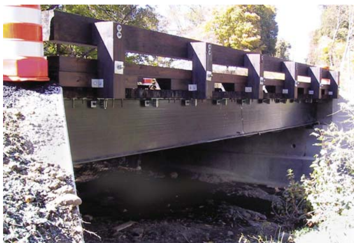
Slika 5.5 Pogled na dokončan most.
