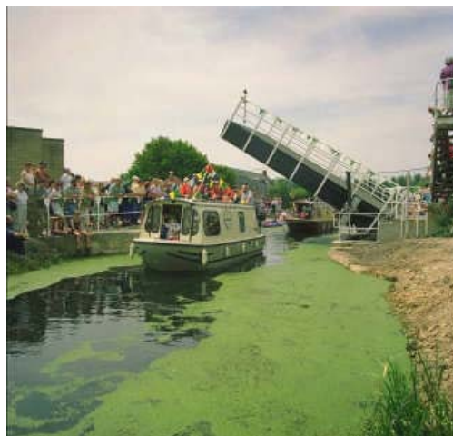
Slika 5.8 Mostna konstrukcija v dvignjenem stanju.
