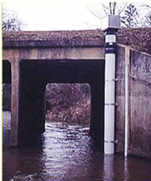
Slika 25: Limnigraf s plavačem ob mostnem oporniku.
