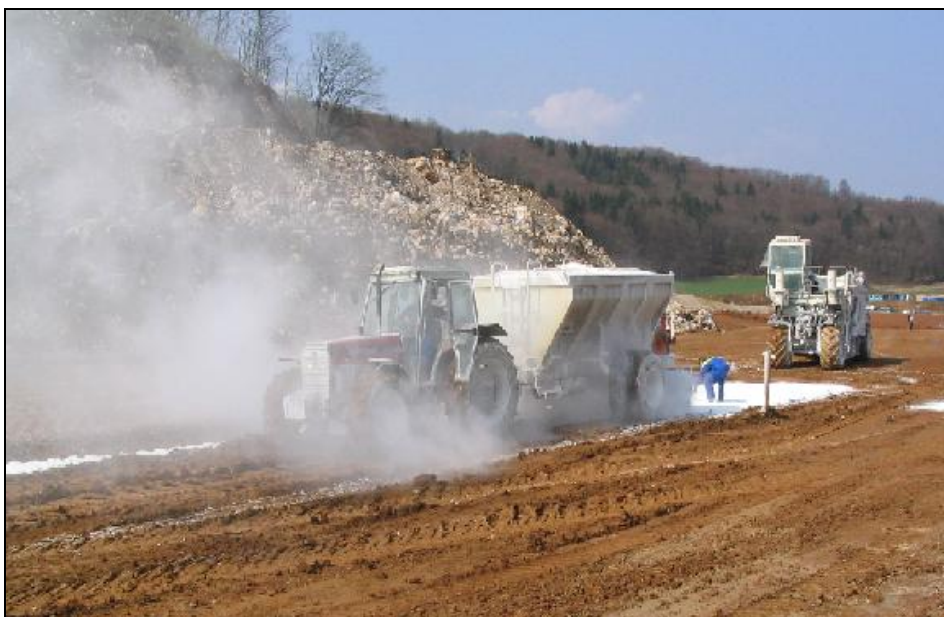
Slika 3.9: Posipanje zemljine z apnom.
