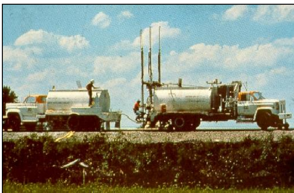
Slika 2.4: Stabilizacija z apnenimi koli.
