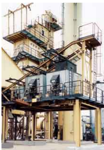
Slika 12: Stabilni kotel za pripravo litega asfalta.
