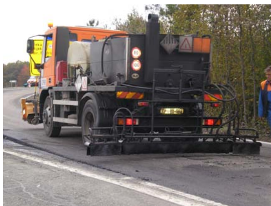
Slika 42, 43: Mazanje stika z bitumensko pasto in pobrizg površine z bitumensko emulzijo.
