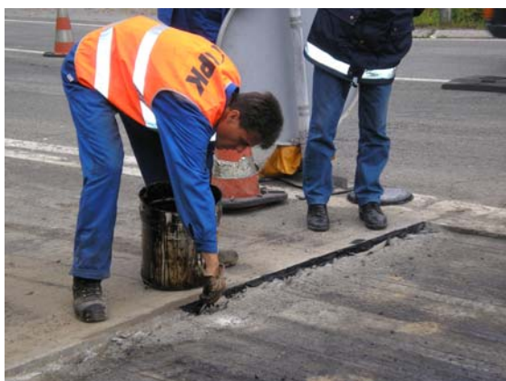
Slika 42, 43: Mazanje stika z bitumensko pasto in pobrizg površine z bitumensko emulzijo.
