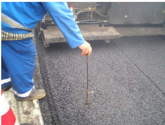
Slika 46: Kontrola debeline razprostrte asfaltne zmesi.
