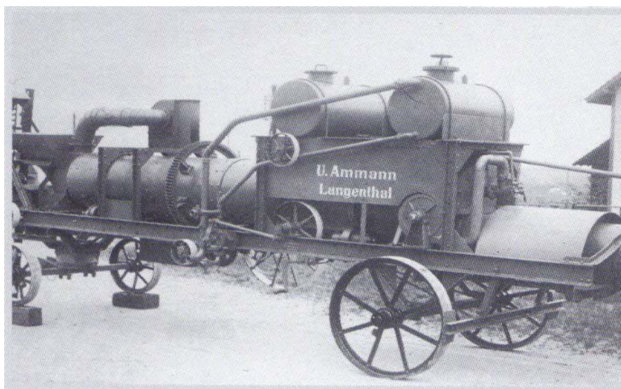
Slika 3: Sušilni boben asfaltne baze iz leta 1925.
