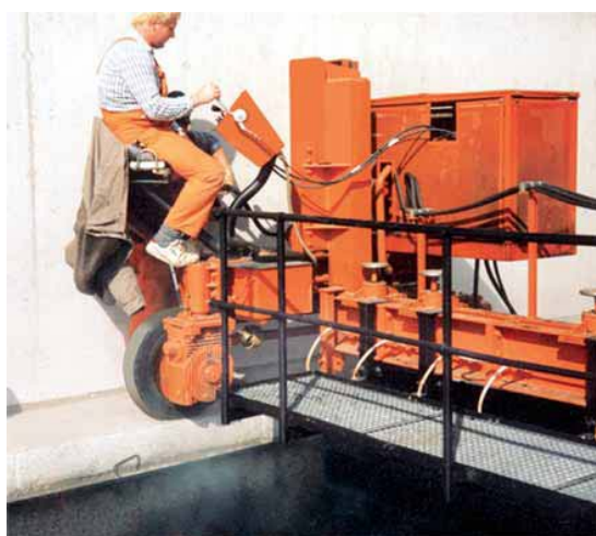
Slika 15: Prekucnik za transport in finišer za vgradnjo litega asfalta.
