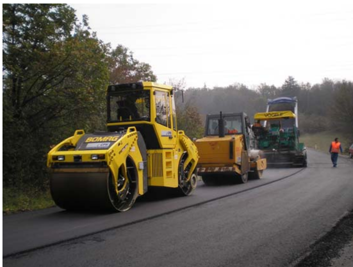
Slika 44: Strojno vgrajevanje asfaltne zmesi na regionalni cesti Sežana–Divača.
