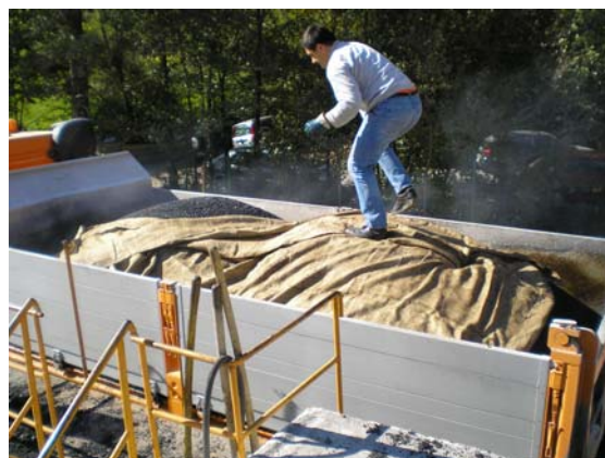
Slika 40, 41: Natovarjanje in pokrivanje asfaltne zmesi.
