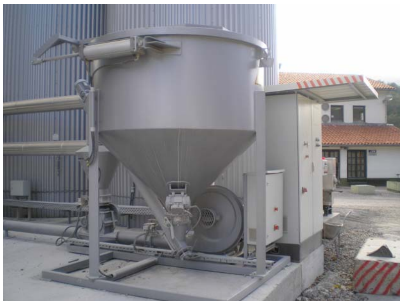
Slika 7: Silos za dodatek (celulozna vlakna).
