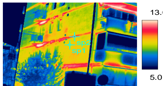
Slika 34: Termografski posnetek stavbe
