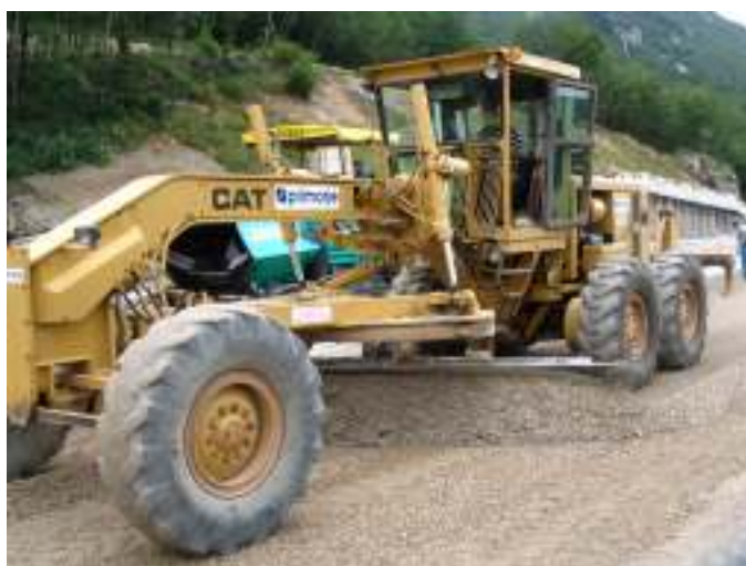
Slika 11: Izdelava stabilizacijske mešanice z grederjem
