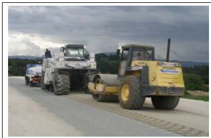
Slika 23: Zgoščevanje z valjarjem BOMAG
