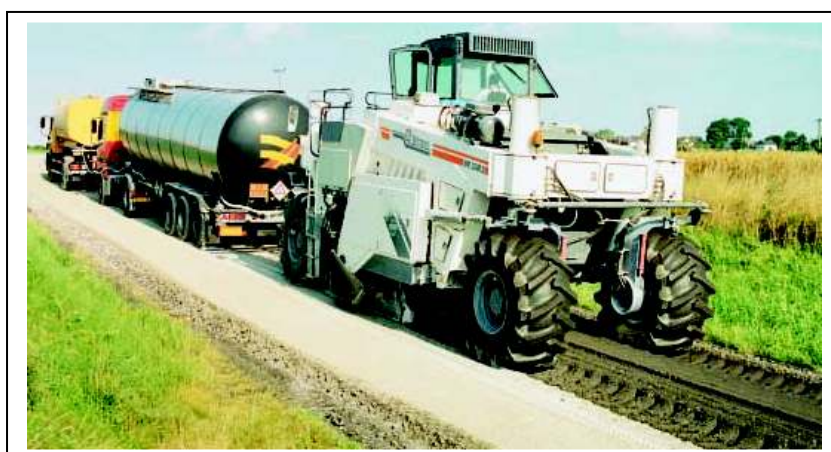
Slika 8: Nadzorovano penjenje bitumna (v ekspanzijsko komoro so vbrizgane majhne količine vode in zraka)
