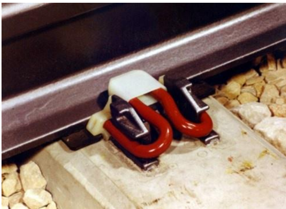
Slika 40: Sistem Pandrol
