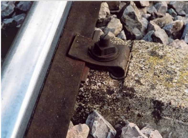
Slika 41: Sistem RN pritrditve
