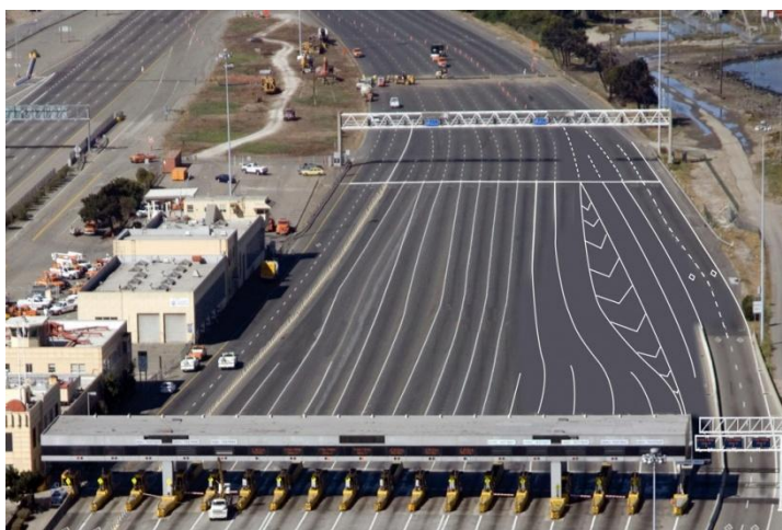
Slika 12: Pogled z vrha na cestninsko postajo po obnovi (MTC, 2009)
