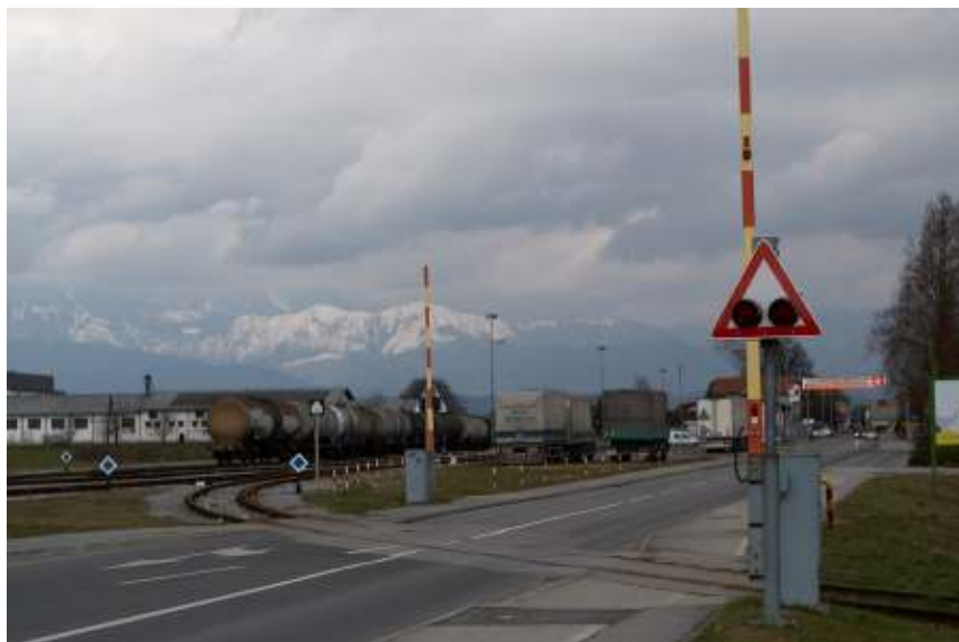
Slika 9: Avtomatska naprava s polzapornicami
