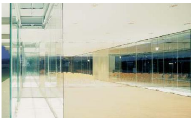
Slika 18: Jekleno streho podpira osem pravokotnih steklenih kvadrov
