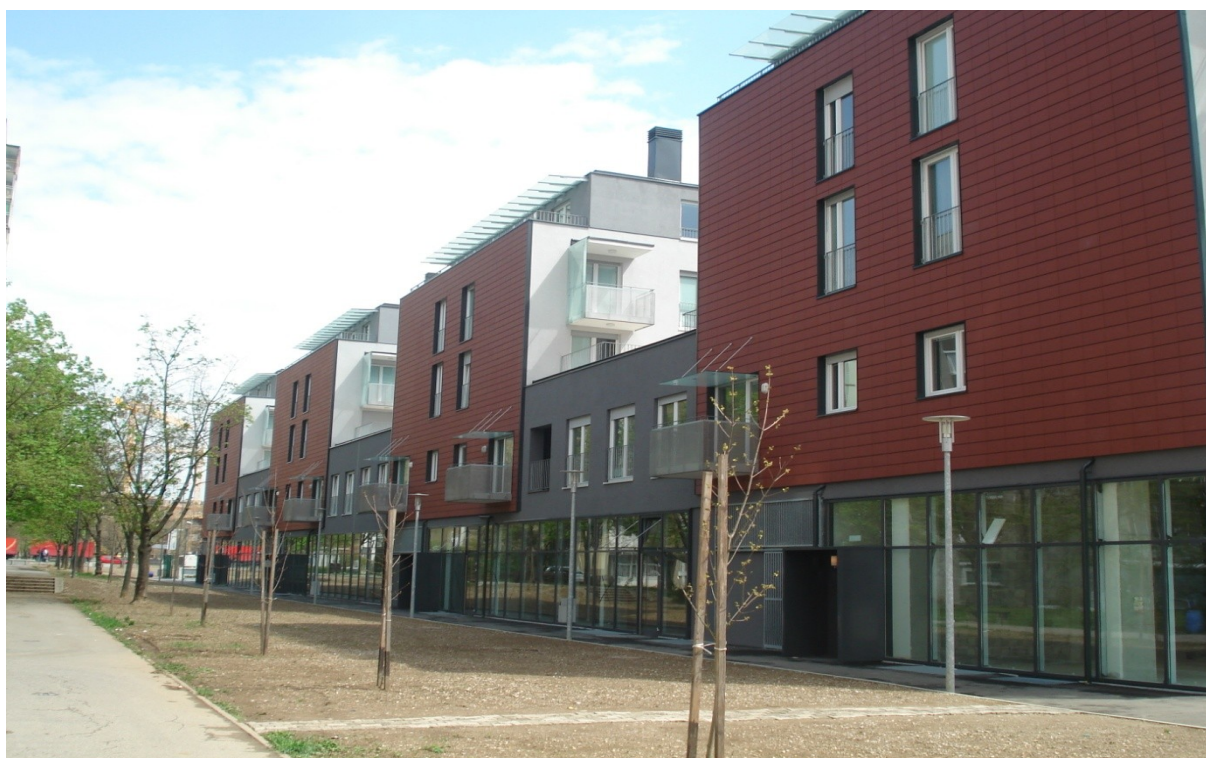
Slika 28 : Sliki končanega objekta SPC na Trgu komandanta Staneta (Vir: dokumentacija gradbišča SPC 03 na Trgu komandanta Staneta, 2007)
