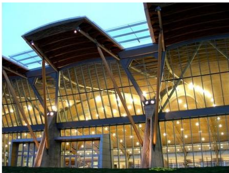
Slika 17: Previs strehe podpirajo podporniki iz lepljenih lameliranih elementov ( http://www.naturallywood.com/.../Richmond Olympic Oval Case Study(1).pdf , pridobljeno 23.1.2011)
