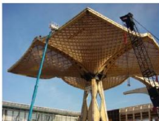
Slika 36: Postavitev prvega »dežnika«
