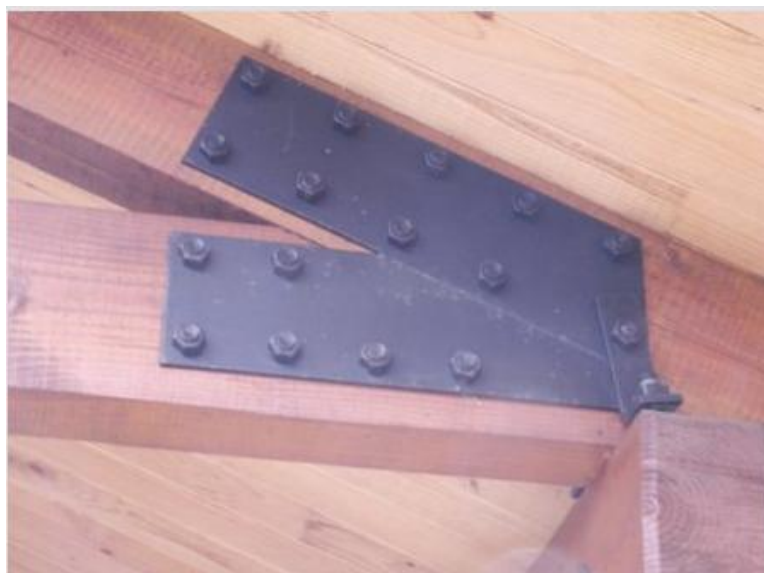
Slika 9: Povezava med elementi paličja, ki že prevzema momente, imenovana »heel joint« ( http://www.forestryforum.com/board/index.php?topic=29272.20 , pridobljeno 17.1.2011)
