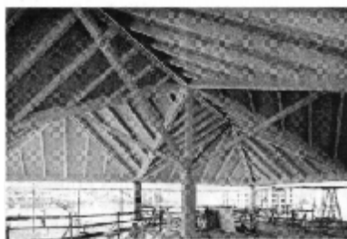
Slika 21: Prostorska strešna konstrukcija, zgrajena leta 1981 (Natterer, 2004, str. 17)
