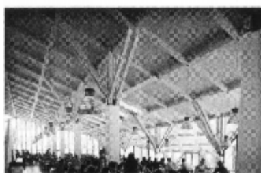
Slika 20: Prostorska strešna konstrukcija, zgrajena leta 1980 (Natterer, 2004, str. 17)
