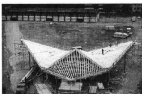
Slika 25: Rebrasta lupinasta konstrukcije v Rosenheimu, Nemčija, iz leta 1972 (Natterer, 2004, str. 19)
