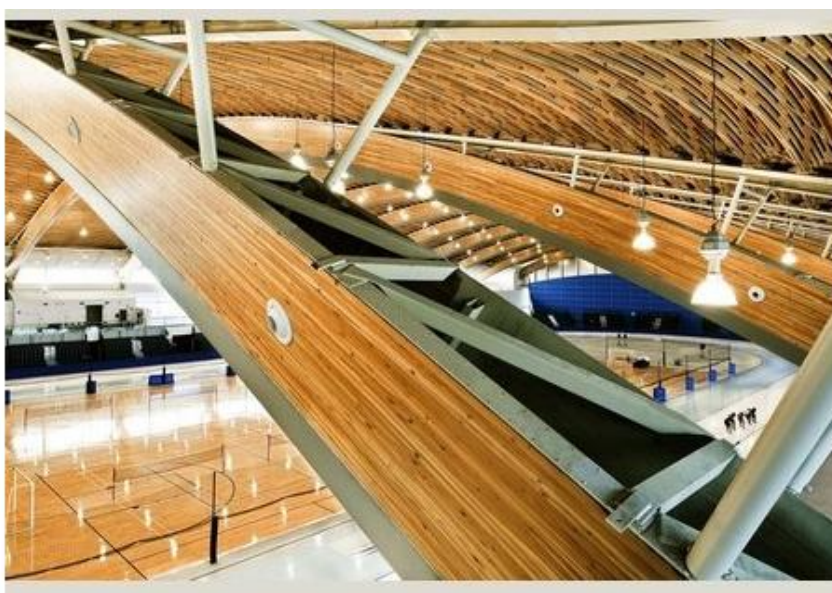
Slika 14: Lepljeni lamelirani nosilci v kombinaciji z jeklom
