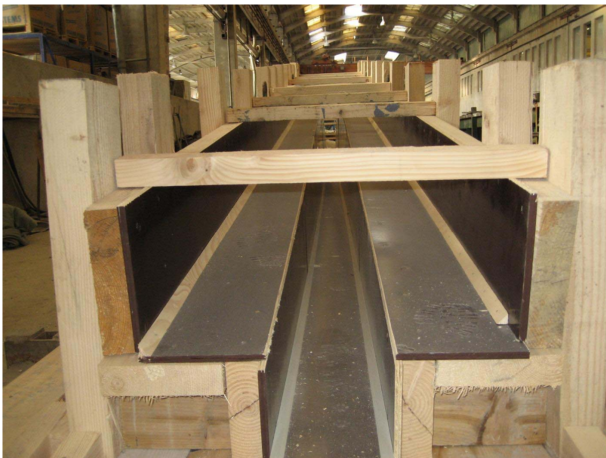
Slika 22: Lesen opaž za izdelavo montažnega nosilca s t prečnim prerezom.
