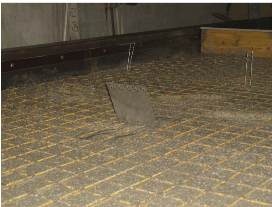
Slika 13: Povezovalna sredstva v fasadnih elementih debeline 26 cm
