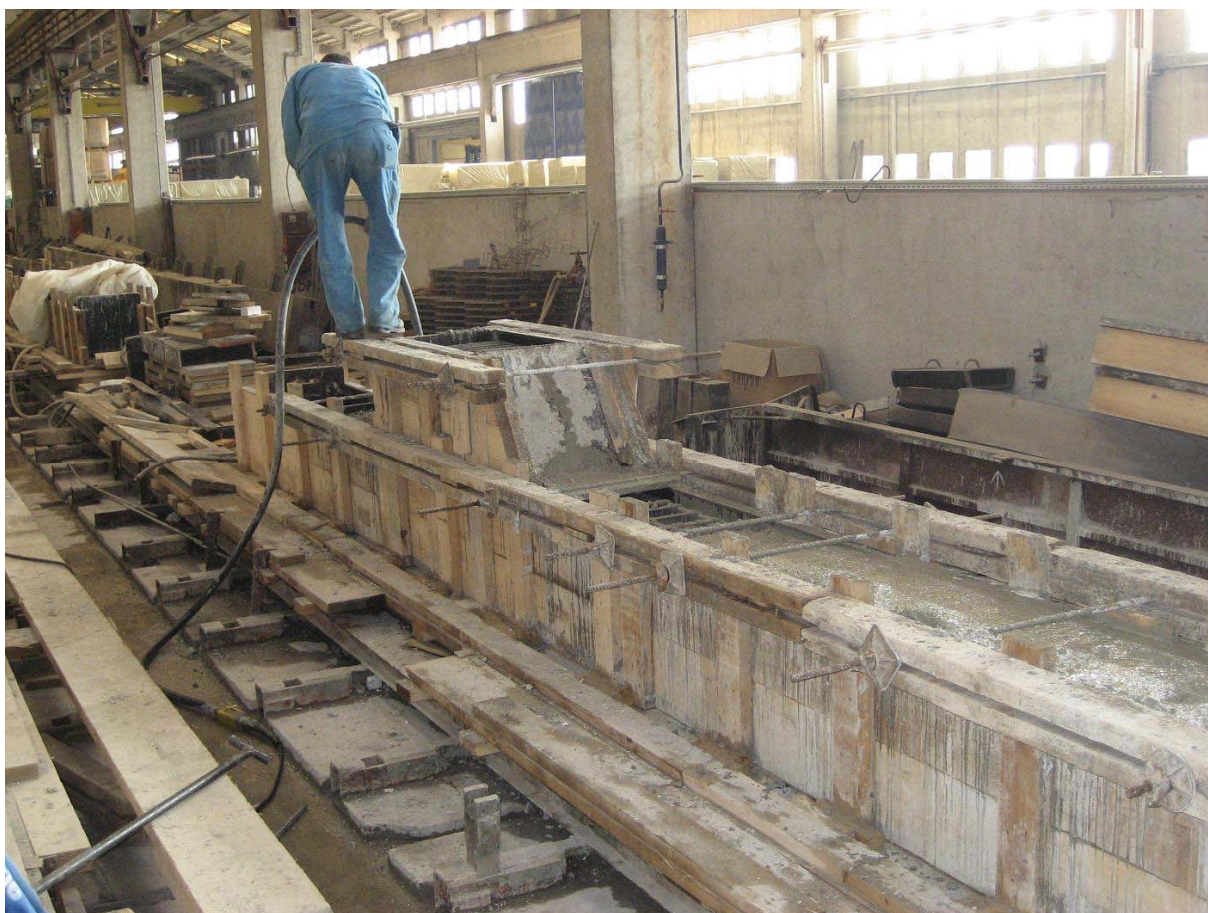
Slika 21: Kompaktiranje betona stebra z iglastim vibratorjem.
