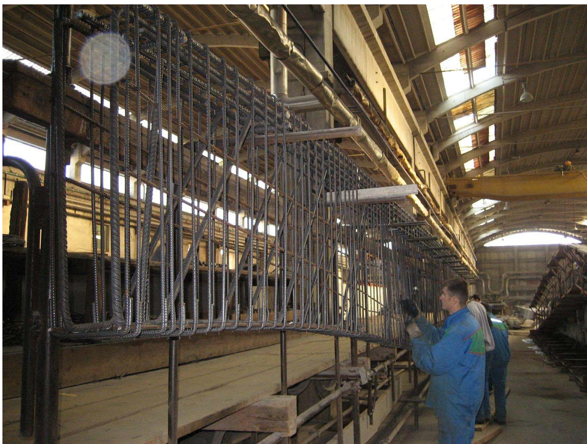
Slika 20: Vežanje armature dvokapnega nosilca.
