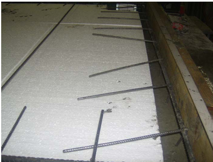
Slika 8: Toplotni most pri 20-centimetrskem fasadnem elementu
