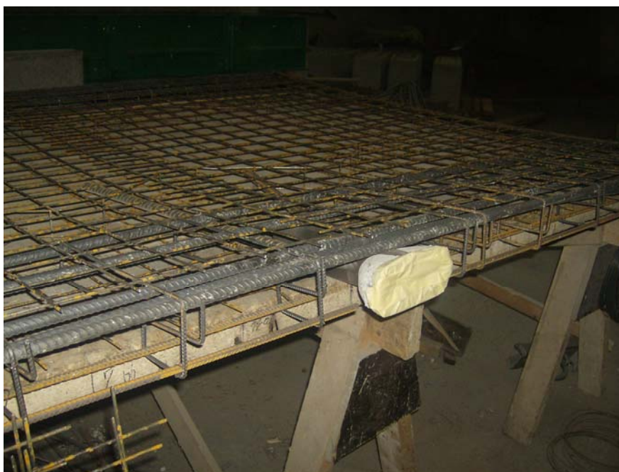
Slika 10: Armatura nosilnega sloja fasadnega elementa
