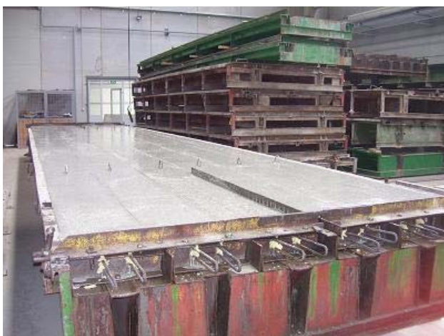
Slika 2: Pravkar zabetonirane gredice
