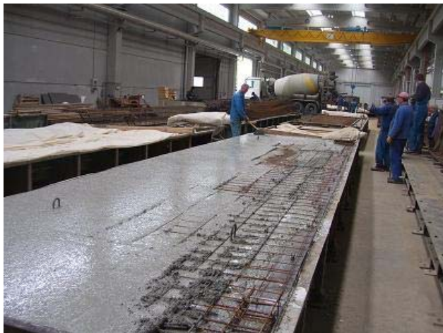
Slika 1: Postopek betoniranja pi plošče z uporabo samozgoščevalnih betonov
